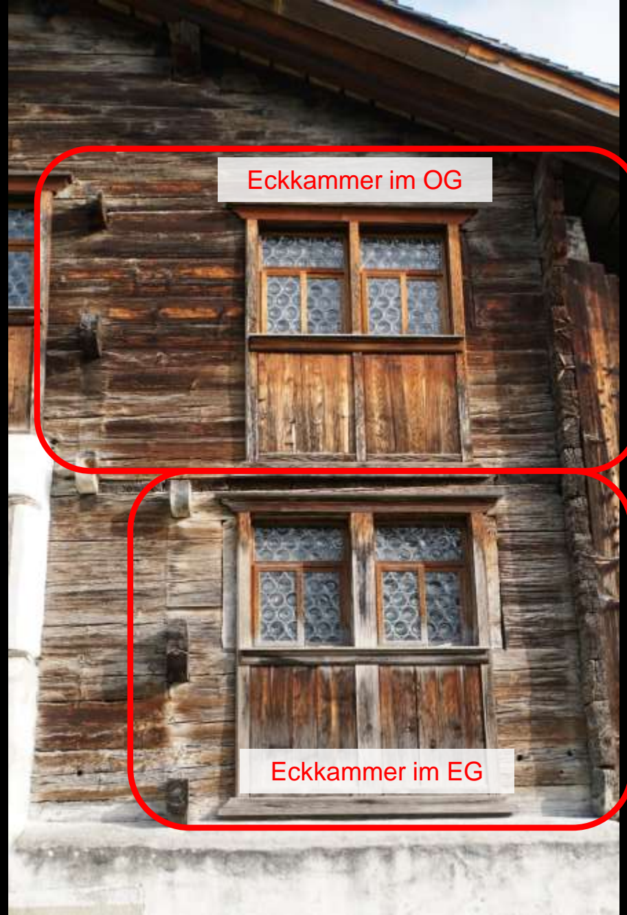
Schwyz, Haus Bethlehem (1287) Eckkammern als stabile Eckversteifung
