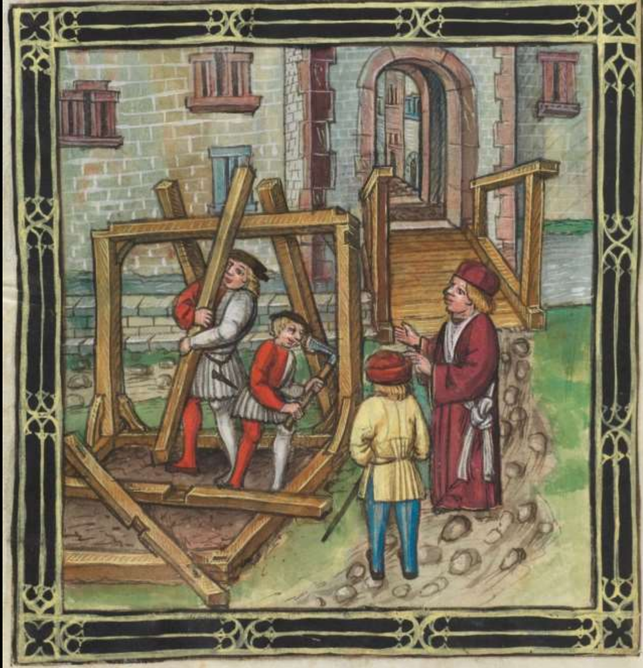
Aufrichten eines Fachwerkbaus (Diebold Schilling, Eidg. Chronik, 1511, Korp. Luzern S 23) (der Abt von Kreuzlingen beschwert sich über ein unrechtmässig errichtetes Schützenhaus)
