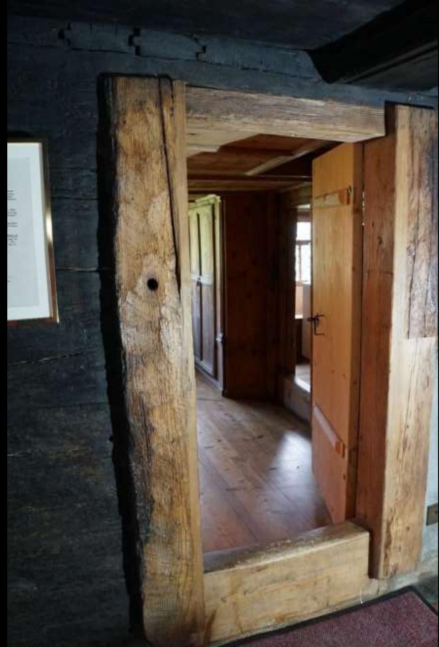
Schwyz, Haus Bethlehem (1287): Öffnungen Türöffnungen durch „Mantelstud“ (Wandständer) stabilisiert und mit hoher Schwelle
