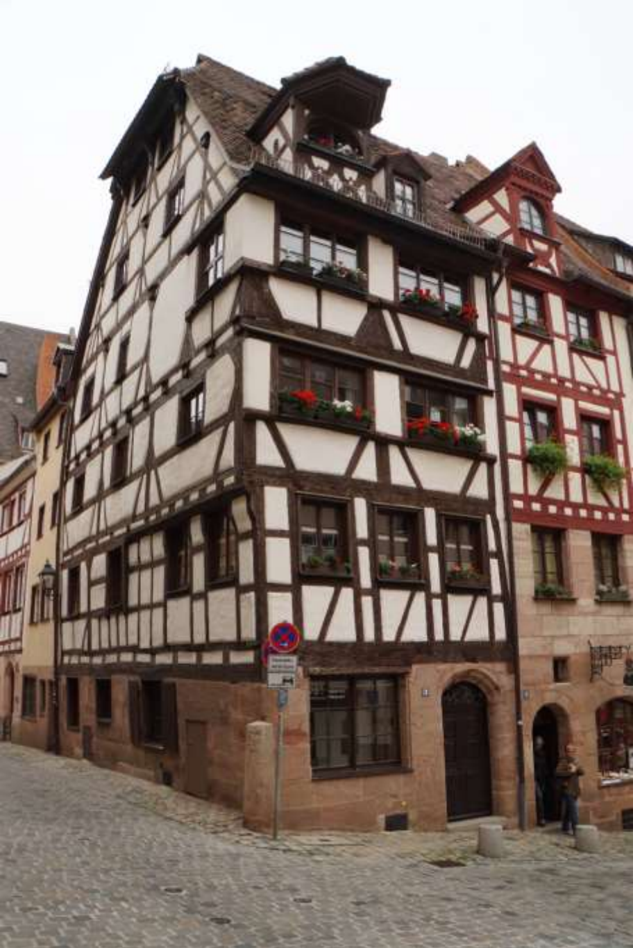
Nürnberg, Untere Krämersgasse 18 (1454/77). Stockwerksbauweise (Balkenköpfe, Schwelle!)
