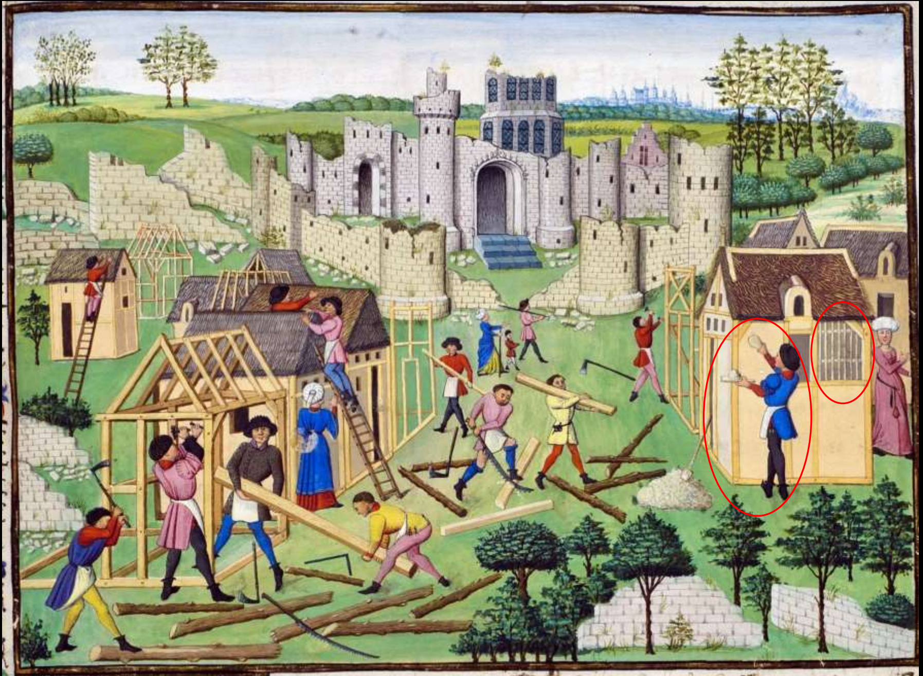
Aufrichten, Ausfachen und Verputzen von Fachwerkhäusern (Brüssel, Bibliothèque Royale, Histoire d'Hainault, Ms. 9242, Bd. I, fol. 232, 15. Jh.)
