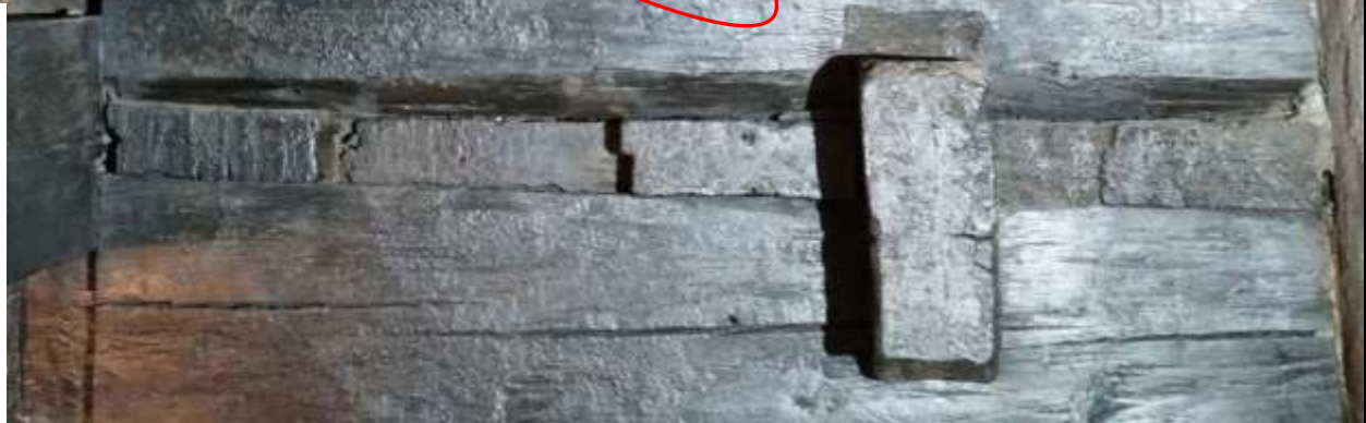
Schwyz, Haus Bethlehem (1287) Dachkonstruktion als Pfettendach
