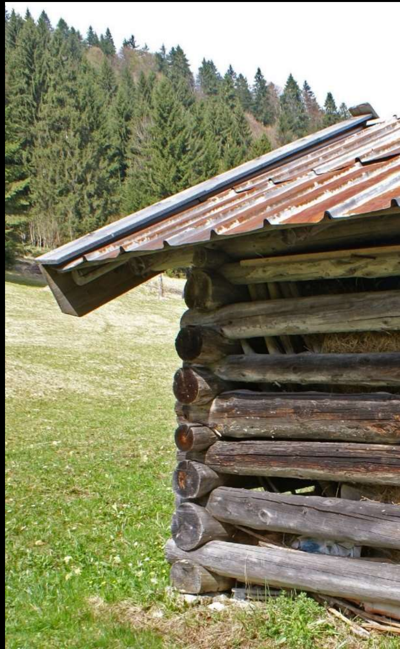
Offener Rundholzblock (Gschwend 1983) Eckverschränkung, Vorholz (Vorstoss) notwendig zur Stabilität
