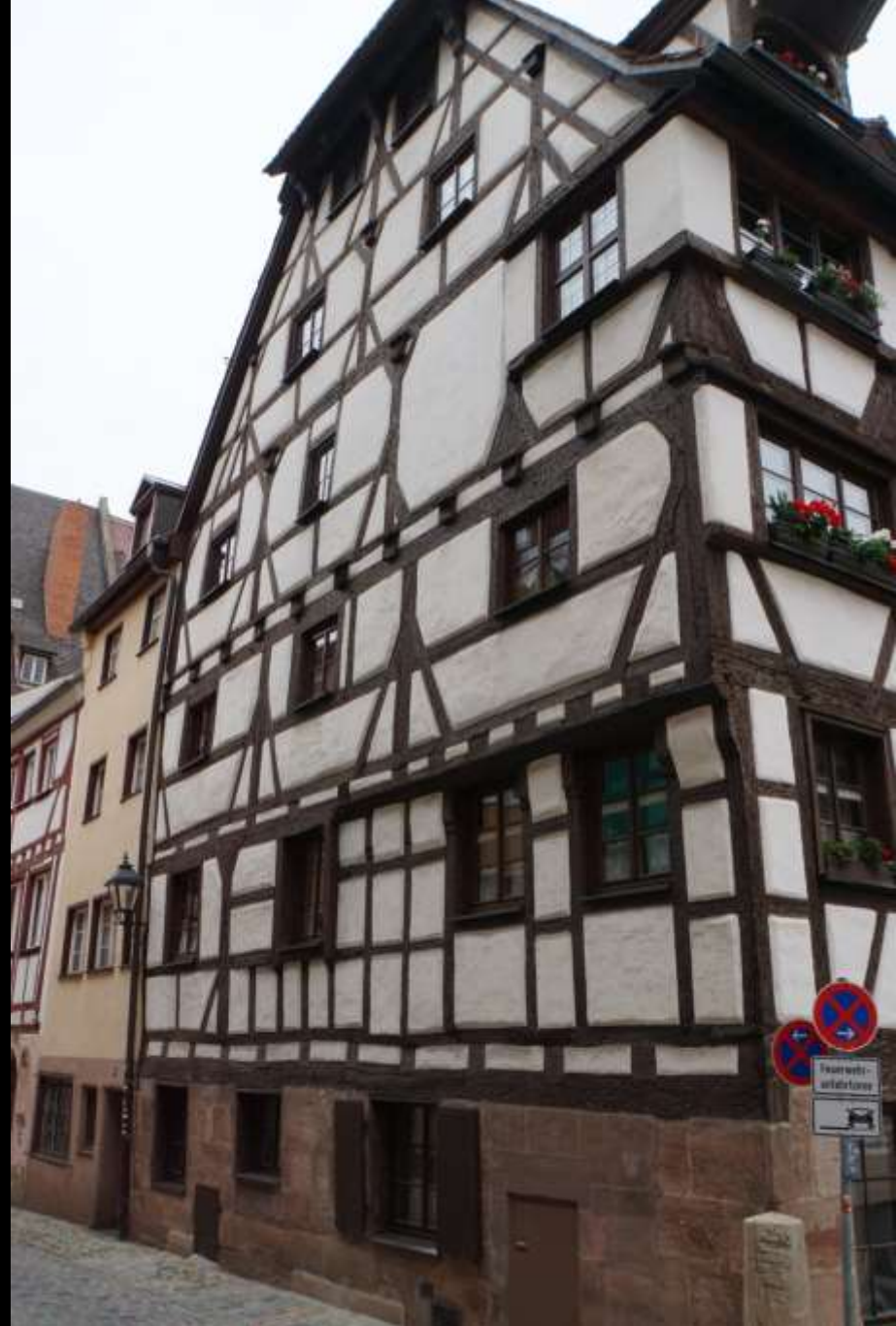
Nürnberg, Untere Krämersgasse 18 (1454/77). Stockwerksbauweise (Balkenköpfe, Schwelle!)
