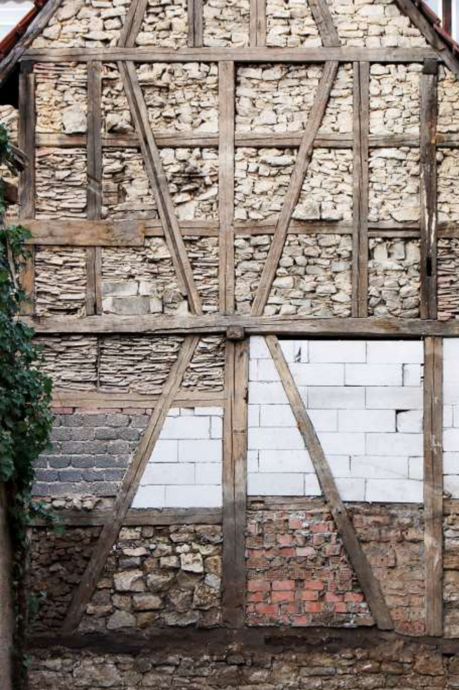
„Fachwerkbau“: Füllung der Gefache mit Mauerwerk (Markgröningen) oder Flechtwerk (Unterstammheim)
