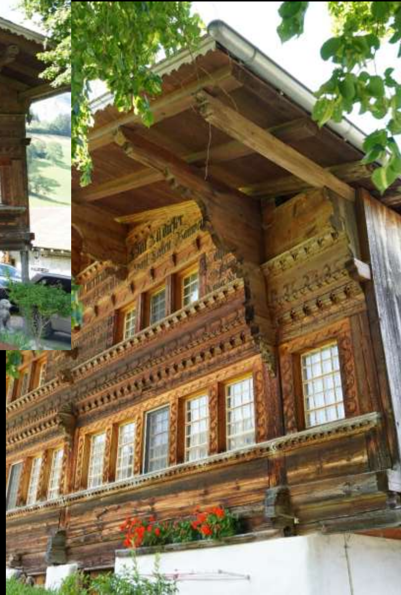
Kombination von Ständerbohlenbau (EG, Reihenfenster!) und Blockbau (OG) (Simmental, 1722; typische Bauweise der Voralpen, Kanton Bern)
