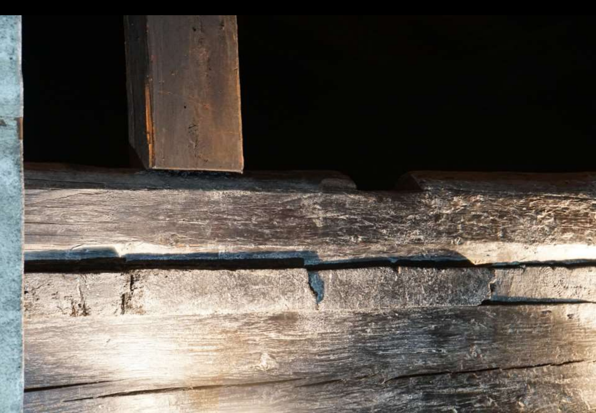
Schwyz, Haus Bethlehem (1287) Deckenkonstruktion aus Bohlen mit Nut und Feder
