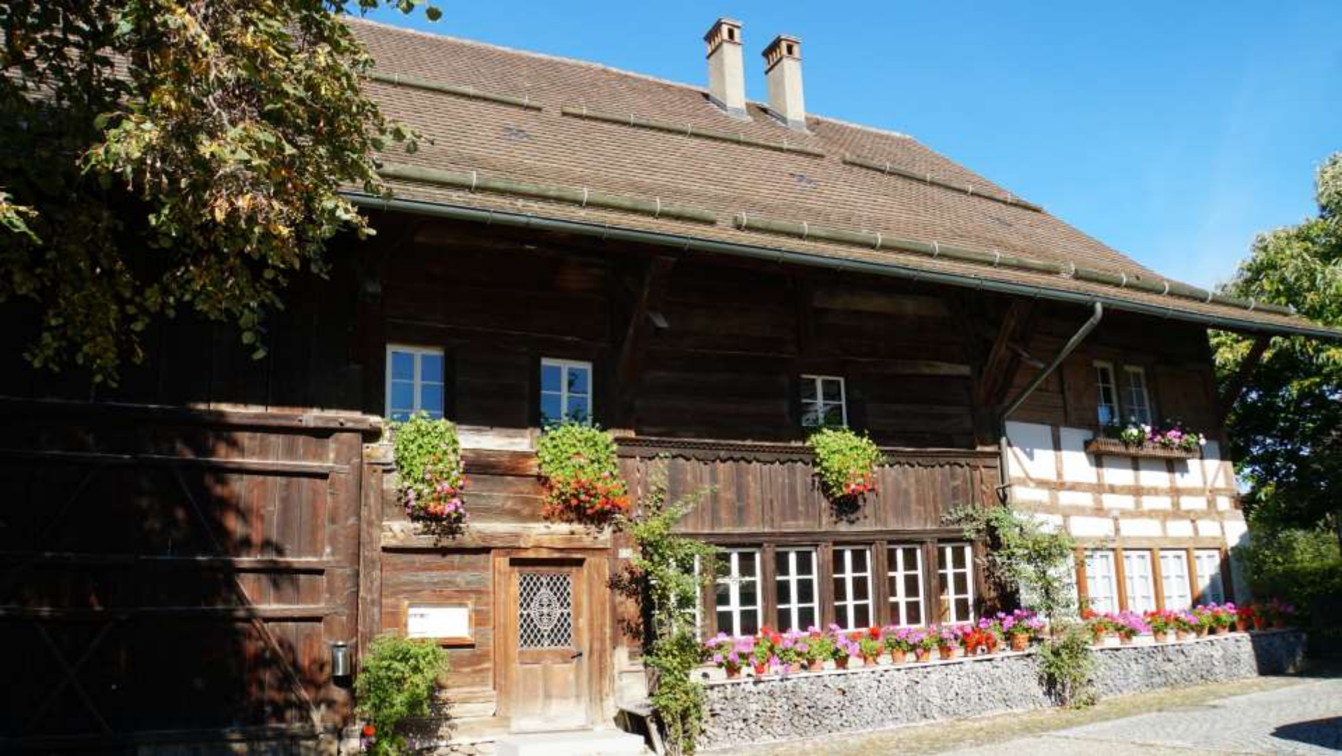
Ständerbohlenbau, im 19. Jh. mit Fachwerkbau erweitert (Typus Vielzweckbauernhaus) (Bücheler-Haus, Kloten ZH, Kernbau 1548; Fotos: Jasmin Schäfer)
