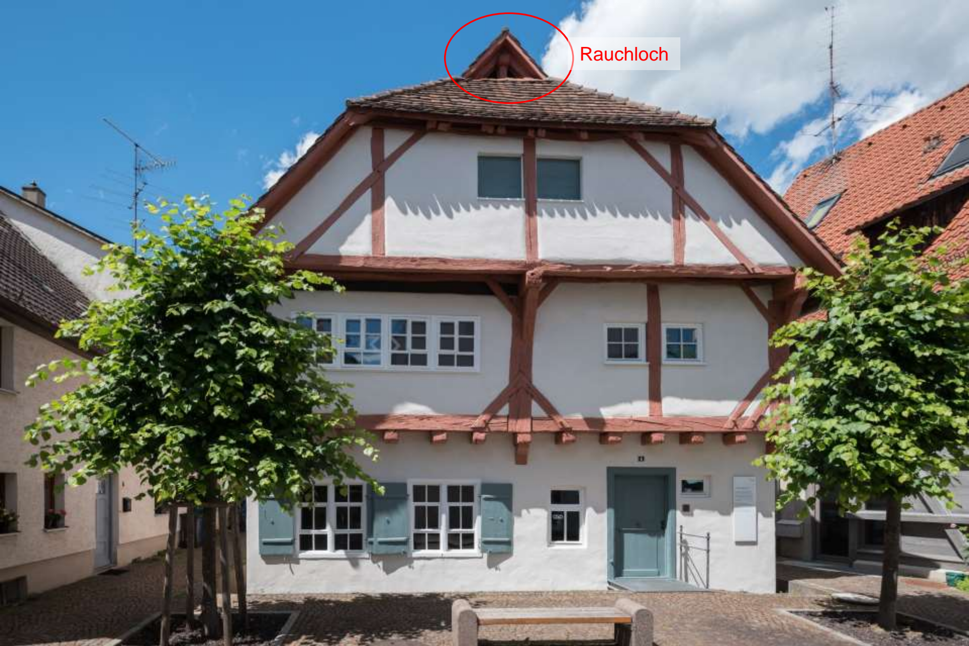
Südwestdeutsches Fachwerkhaus, wohl Haus eines Handwerkers um 1320
