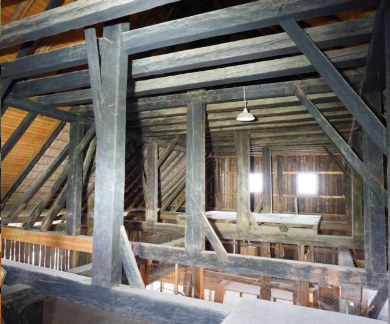
Mehrreihen-Ständergerüst mit abgefangenen Ständern (Bauernhaus Uerzlikon ZH; 16. Jh.)
