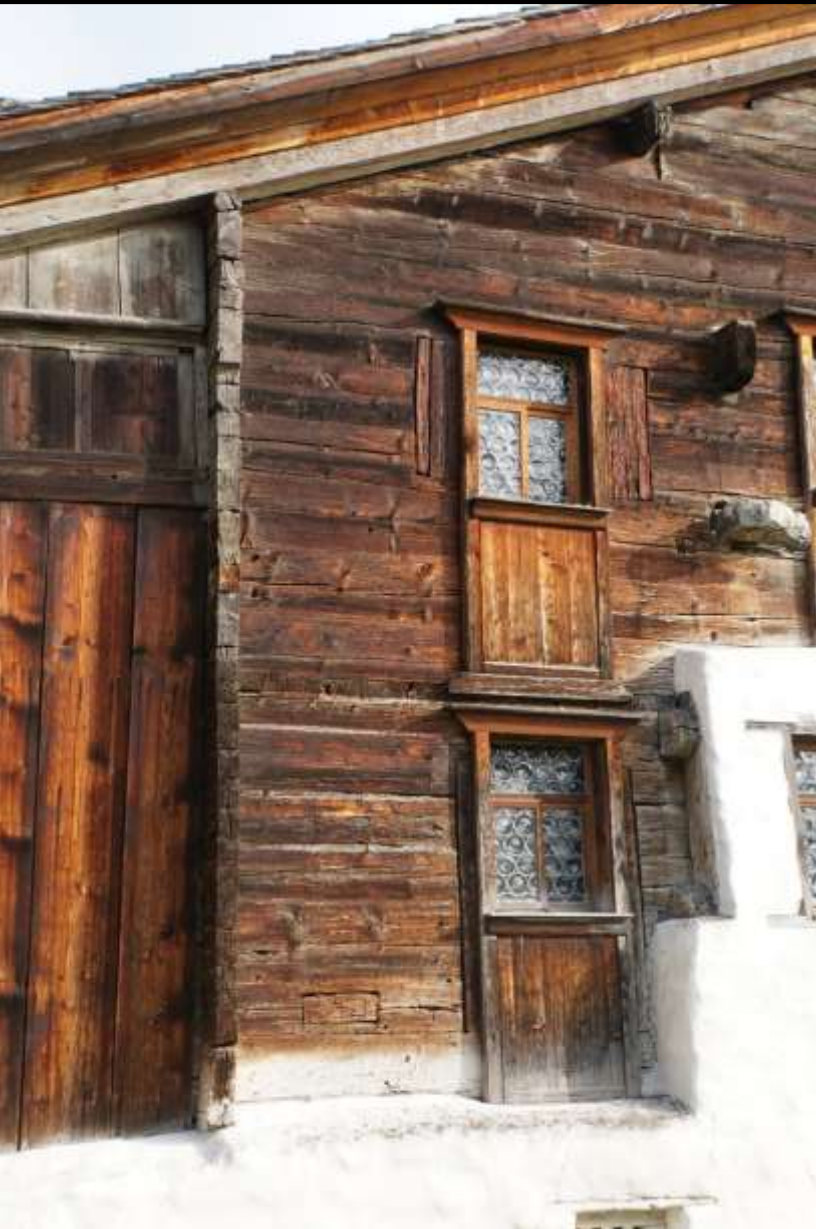
Konstruktion: Massivholzwand in Blockbauweise (horizontal liegende Hölzer) Haus Bethlehem, Schwyz, und Ansicht eines Dorfes (Diebold Schilling, Eidg. Chronik, 1511, Luzern S23)
