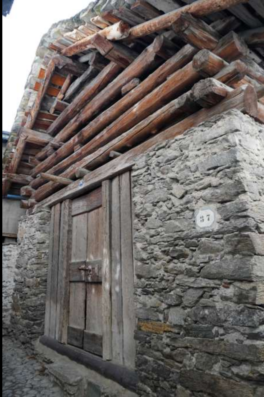
Stallscheune Castasegna GR (1668) mit oberem Scheunenteil in offenem Rundholzblock
