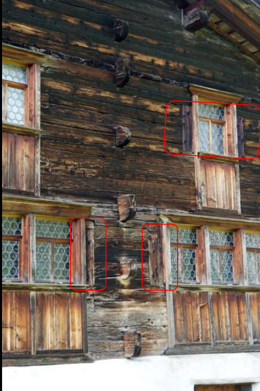
Schwyz, Haus Bethlehem (1287) Spuren älterer, bereits einmal vergrößerter Fenster
