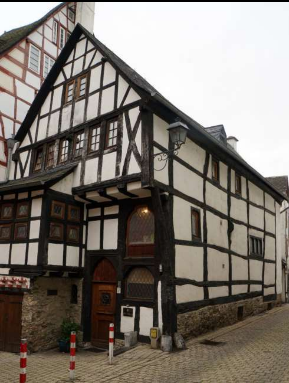
Limburg/Lahn, Kolpingstrasse/Bergstrasse (1291) Gesamtansicht und Querschnitt (U. Klein 1997). Zweigeschossige Wandständer und Aussteifung
