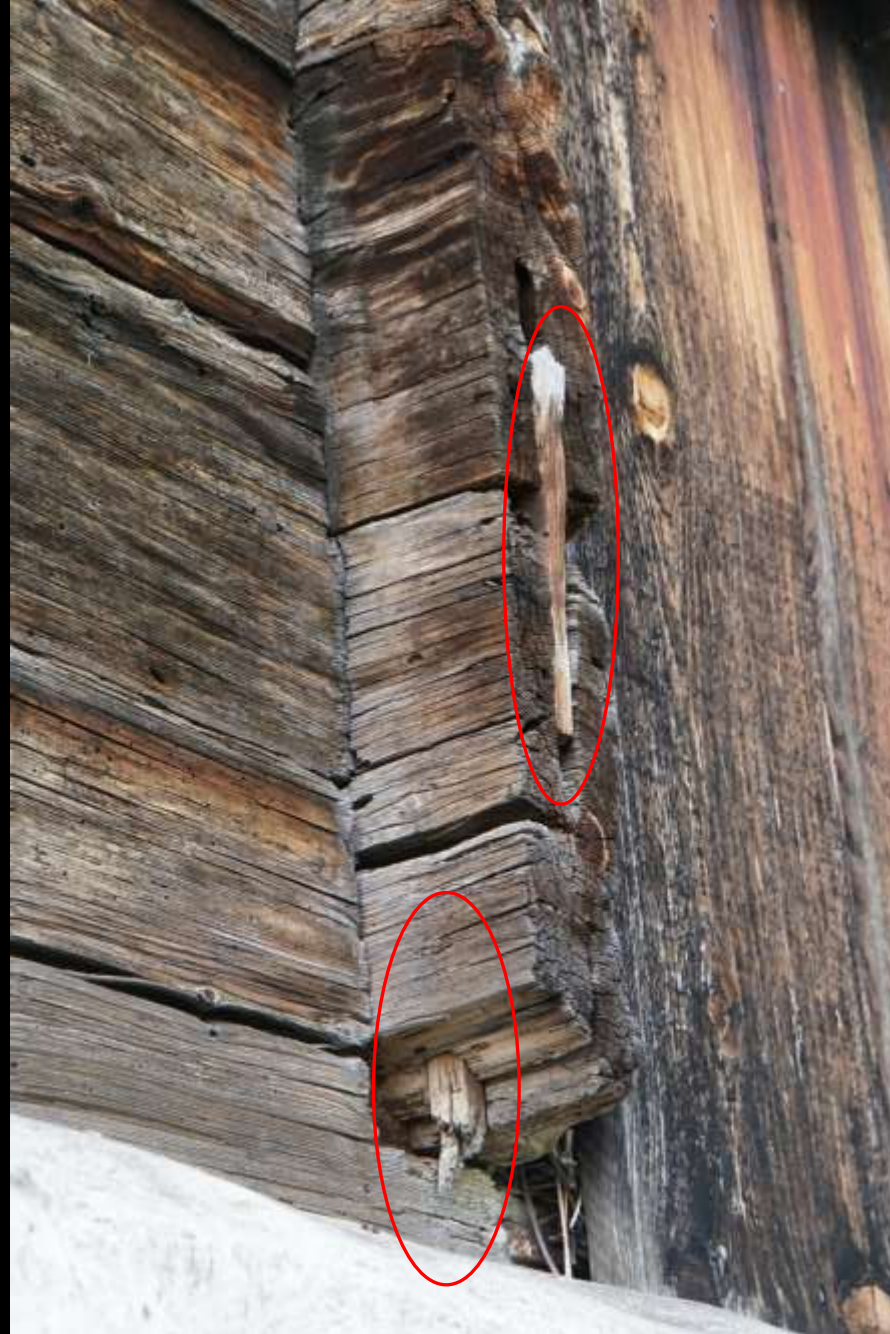
Schwyz, Haus Bethlehem (1287) Ecke mit Vorstössen (später gekürzt, deswegen Dübel sichtbar)
