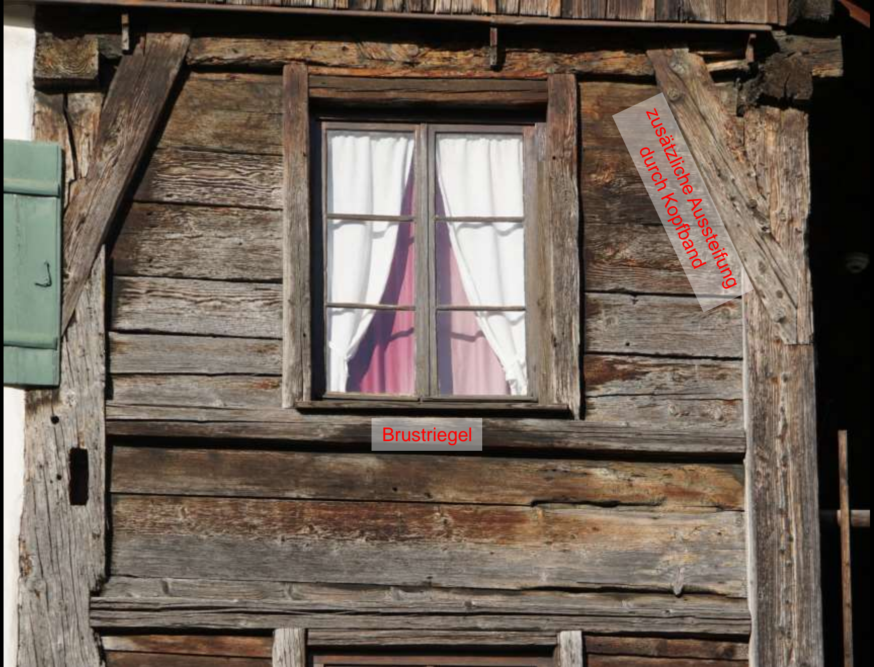
Ausfachung mit liegenden Bohlen, die in die Ständer eingenetet werden (Zürich-Höngg, Haus zum Chranz, 1506)
