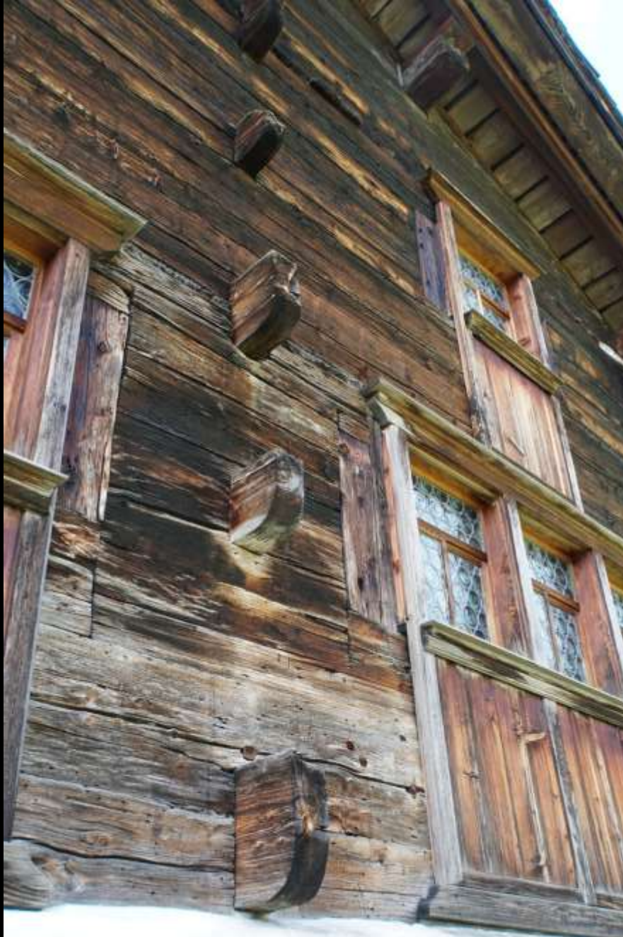
Schwyz, Haus Bethlehem (1287) Einzelvorstösse der Binnenwände im Vorderhaus
