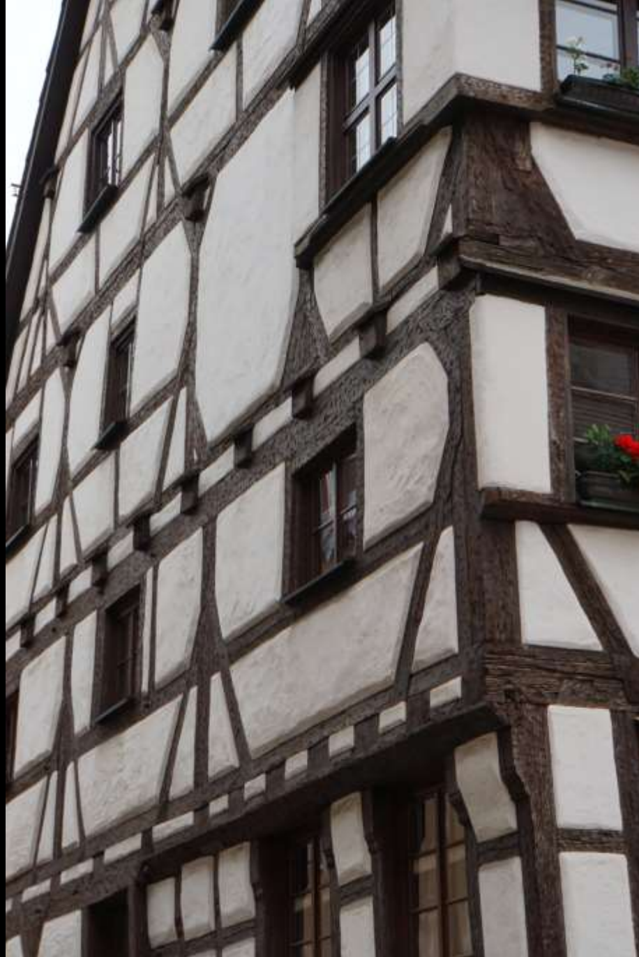
Nürnberg, Untere Krämersgasse 18 (1454/77). Stockwerksbauweise
