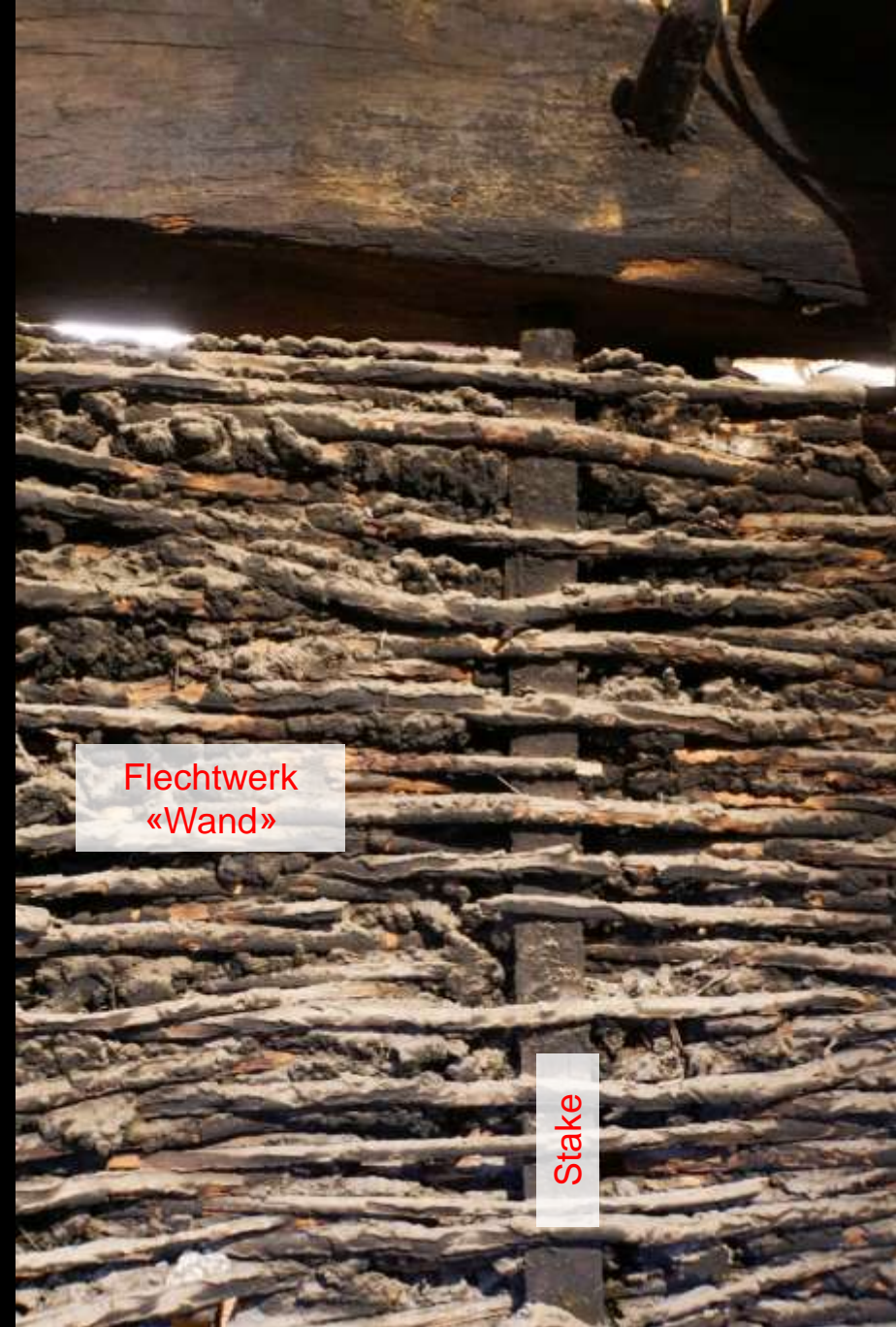
„Fachwerkbau“: Füllung der Gefache mit Mauerwerk (Markgröningen) oder Flechtwerk (Unterstammheim)
