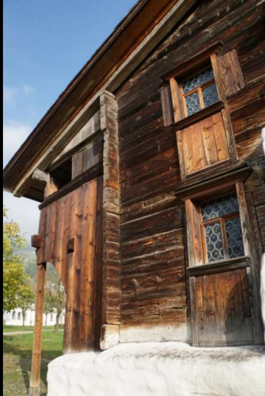
Schwyz, Haus Bethlehem (1287) Ecke mit Vorstössen
