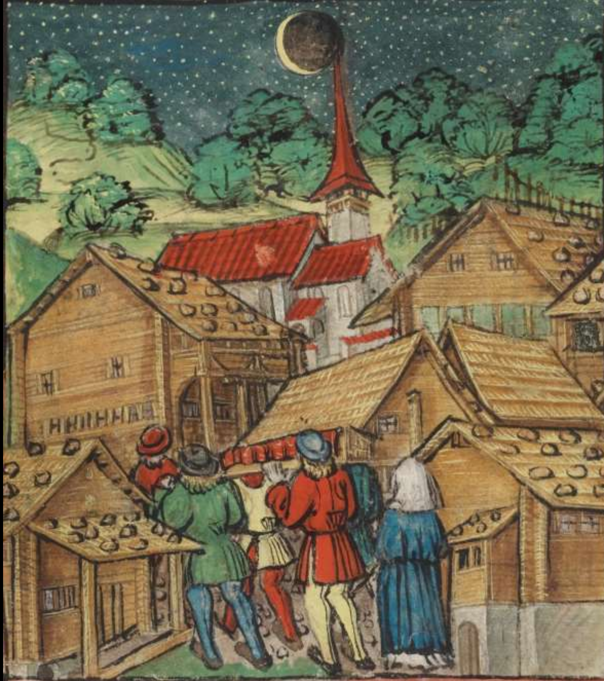
Dachdeckung der flachgeneigten Pfettendächer (hier zu steil dargestellt) durch Legschindeln (Diebold Schilling, Eidg. Chronik, 1511, Luzern S23)
