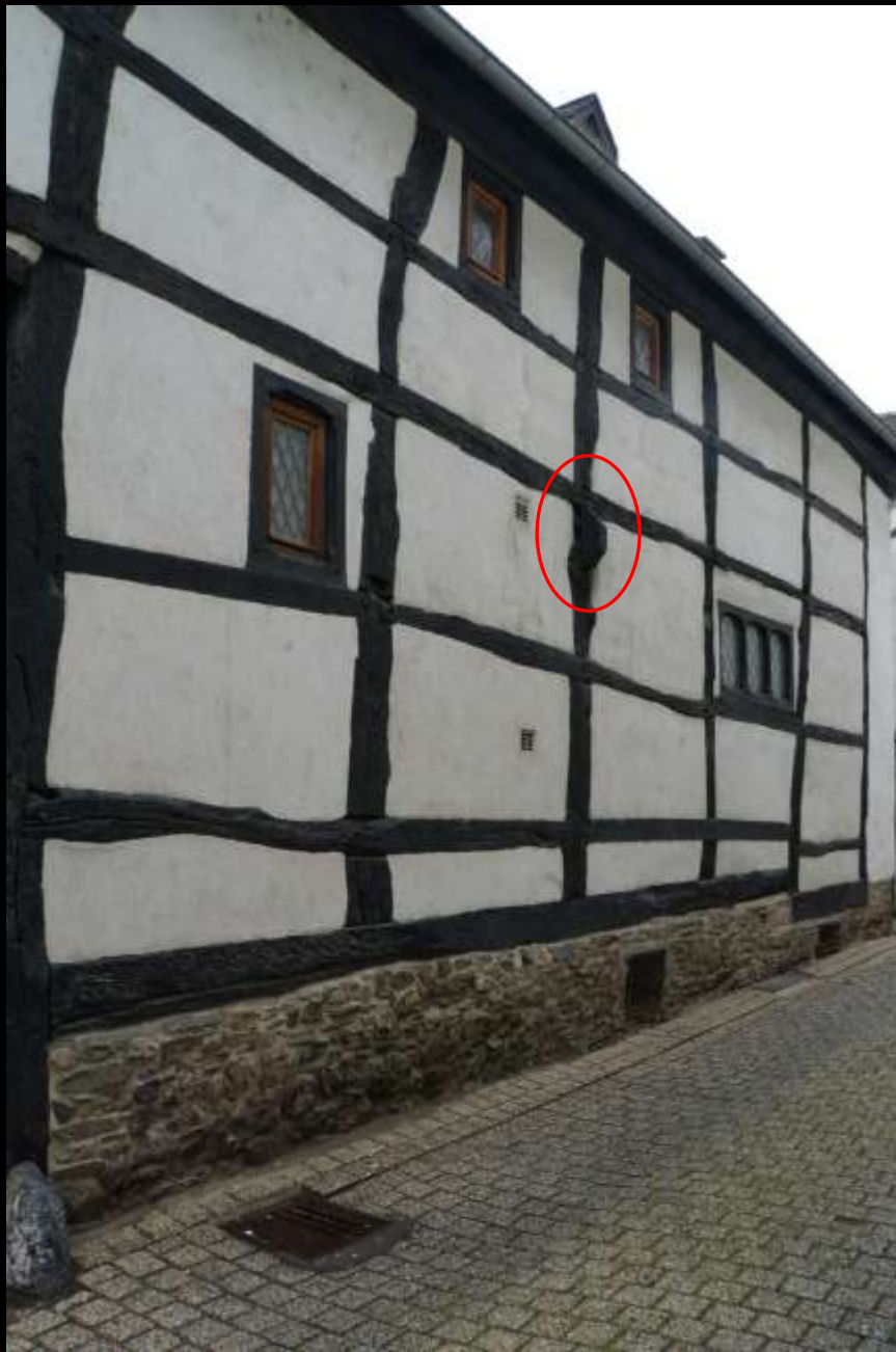
Limburg/Lahn, Kolpingstrasse/Bergstrasse (1291) Ankerbalken mit Zapfenschloss
