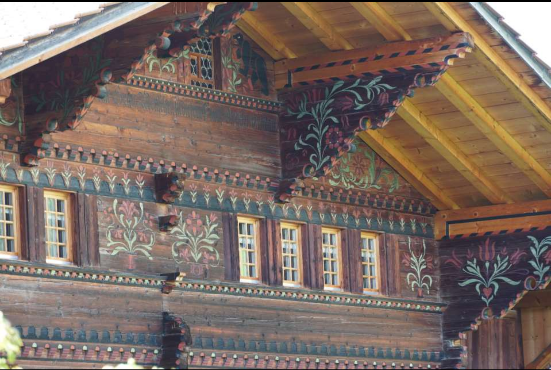
Zweisimmen (BE), Wohnhaus mit oberen Stockwerken in Blockbauweise (17. Jh.)
