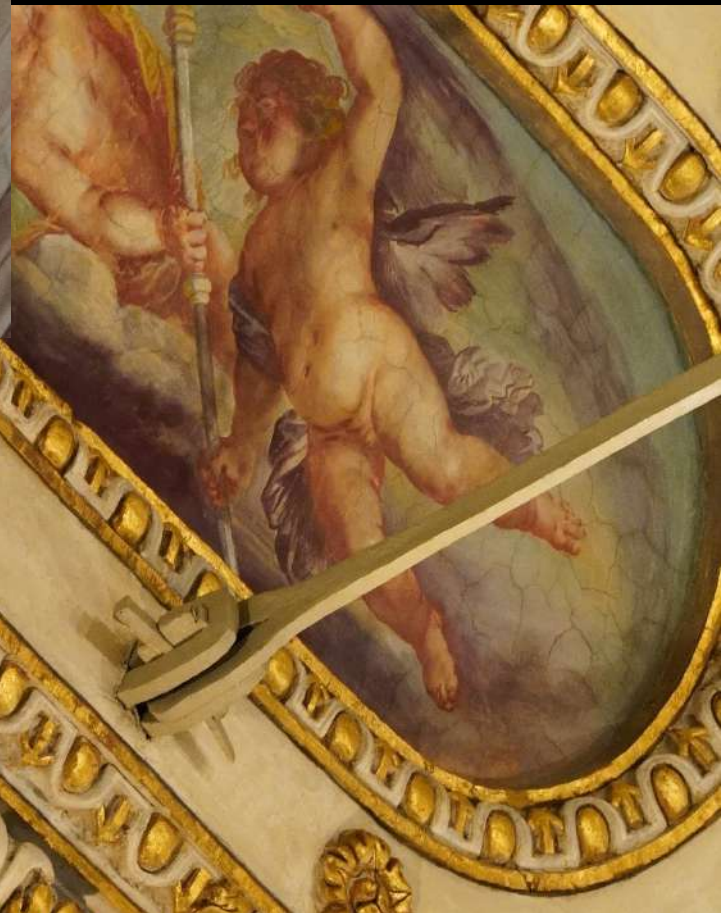
Bauzeitliche eiserne Gewölbeanker (Mailand, Santa Maria presso San Celso und San Vittore al Corpo)
