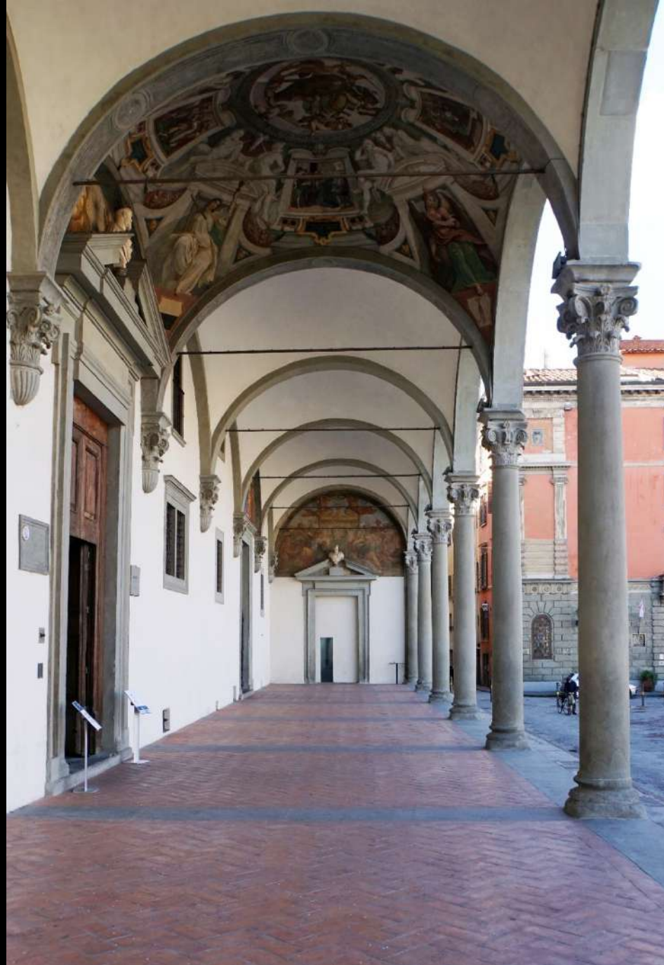
Florenz, Spedale degli Innocenti, Loggia (Filippo Brunelleschi, ab 1419). Wölbung mit Hängekuppeln und Eisen.
