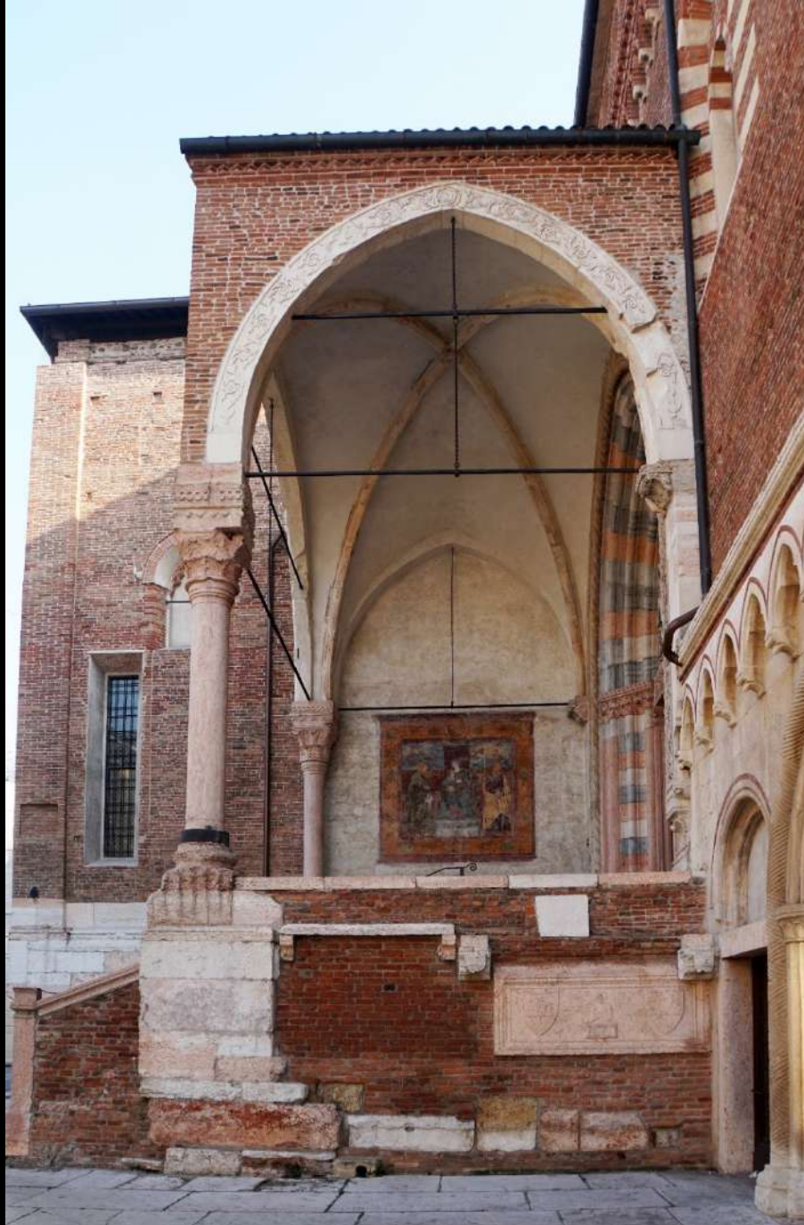
Verona, San Fermo, nördliche Portalvorhalle (um 1400). Spätgotischer Bau, kreuzrippengewölbt, mit Eisenankern
