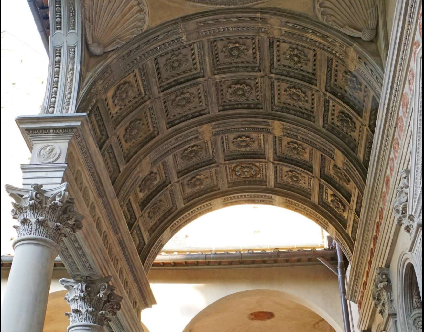
Florenz, Pazzikapelle an Santa Croce, Vorhalle: Kassettierung in Werkstein
