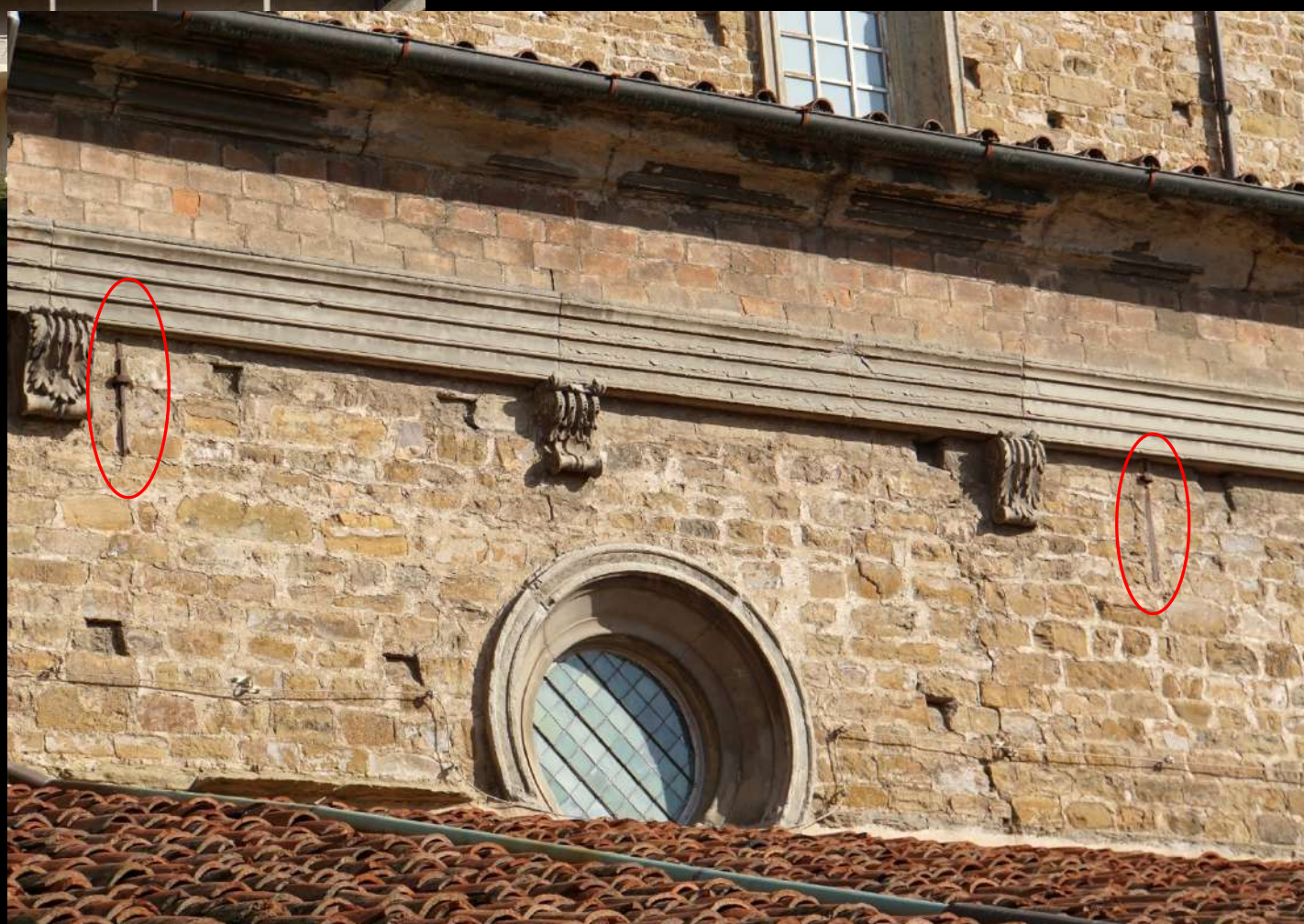
Florenz, San Lorenzo (Filippo Brunelleschi, ab 1434): versteckte Anker der Seitenschiffsgewölbe
