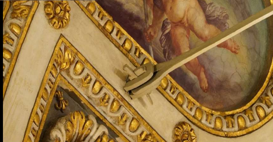
Bauzeitliche eiserne Gewölbeanker (Mailand, Santa Maria presso San Celso und San Vittore al Corpo)
