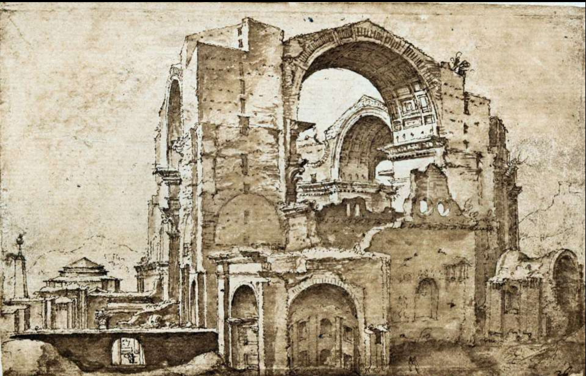
Rom, Petersdom. Die grossen Kuppelbögen (24 m Spannweite) wurden schon 1510/11 errichtet. (Zeichnung Maarten van Heemskerck, um 1535, aus Geymüller 1875)
