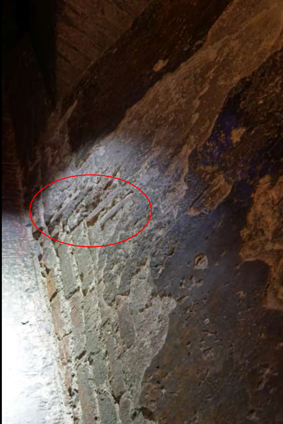
Florenz, Dom. „Spinapesce“-Mauerwerksverband in der Kuppelschale
