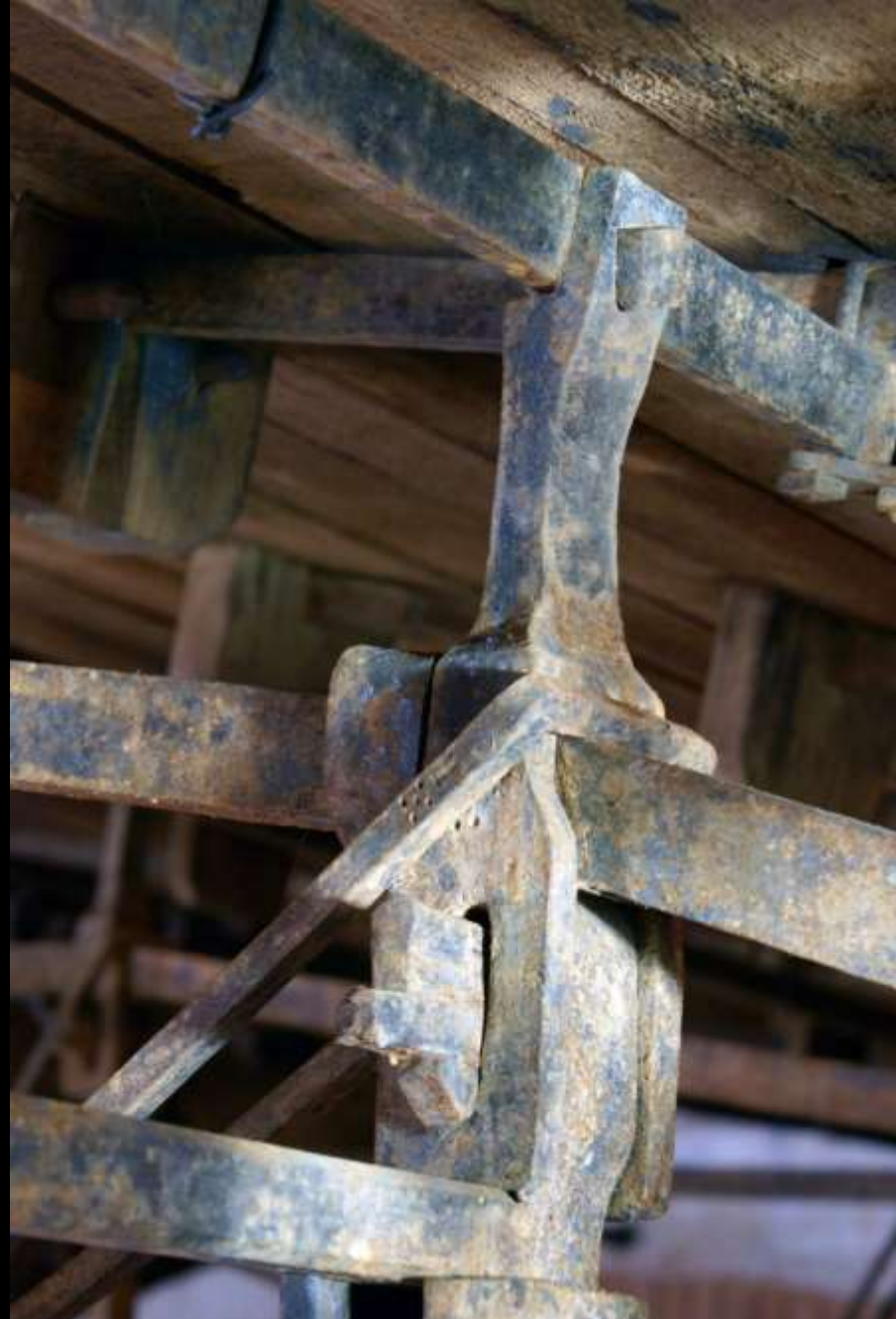
Walhalla bei Regensburg, „Adyton“: Anschlussdetail mit Keil und Gegenkeil, „Abbundmarken“ (Leo v. Klenze und „Mechanicus Manhard“ 1836-40)
