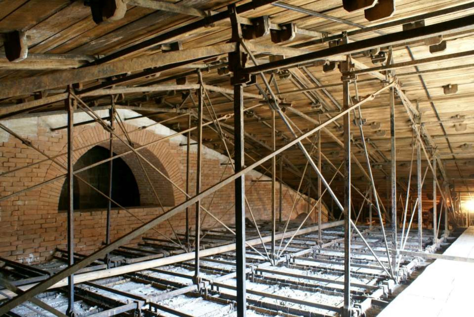
Walhalla bei Regensburg: Dachwerk über dem „Adyton“: eisernes „Bogenhängewerk“ (Leo v. Klenze und „Mechanicus Manhard“ 1836-40)
