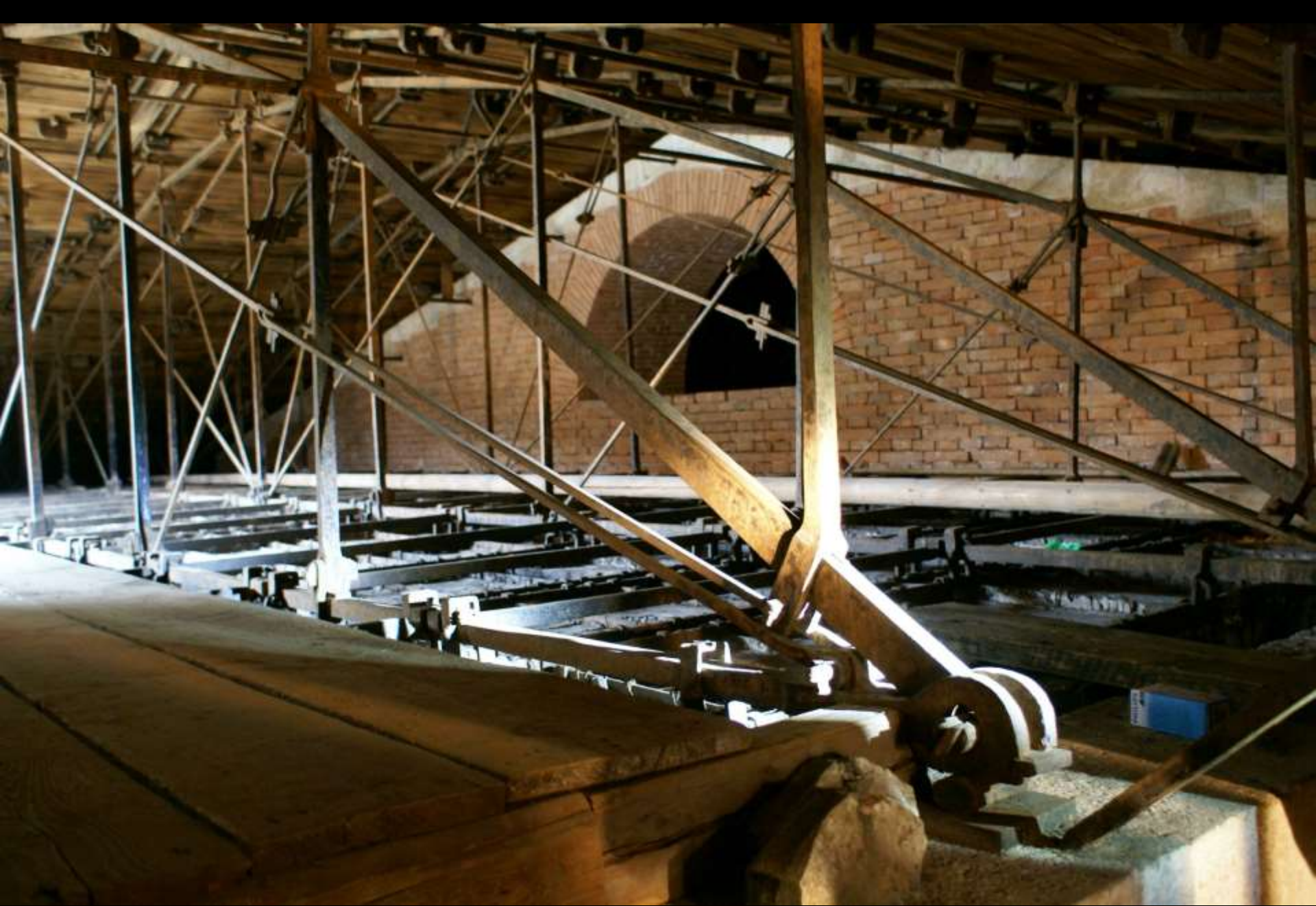
Walhalla bei Regensburg: Dachwerk über dem „Adyton“ (Leo v. Klenze und „Mechanicus Manhard“ 1836-40)
