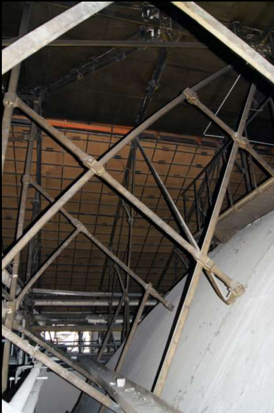
Paris, Dachkonstruktion der Börse (1821-27) Kuppelschale aus Tonhohlkörpern
