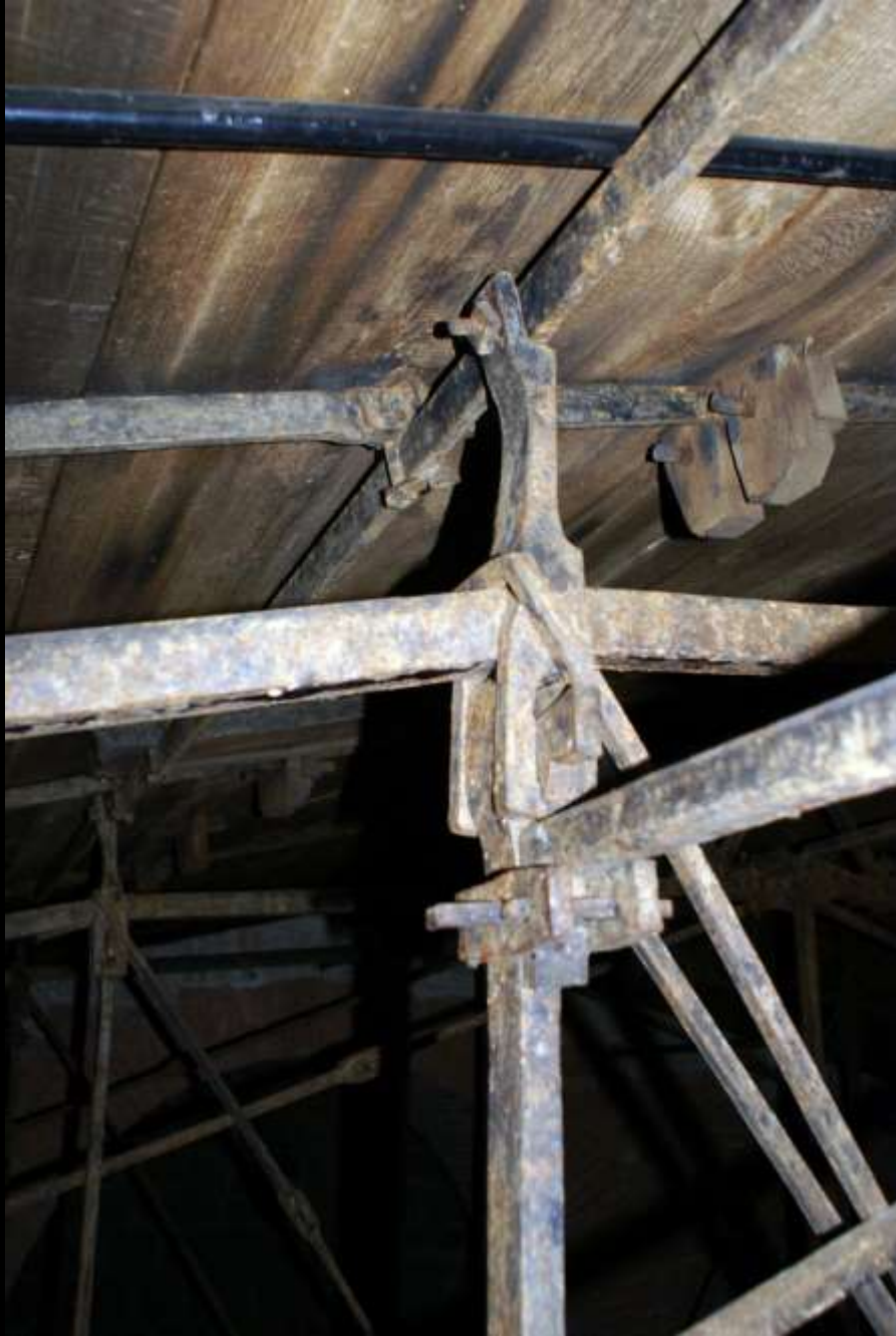
Walhalla bei Regensburg, „Adyton“: Anschlussdetail mit Keil und Gegenkeil, „Abbundmarken“ (Leo v. Klenze und „Mechanicus Manhard“ 1836-40)
