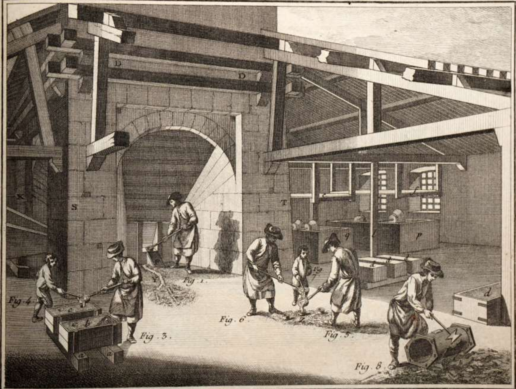
Direkter Guss von Roheisen aus dem Hochofen (Encyclopédie 1765)
