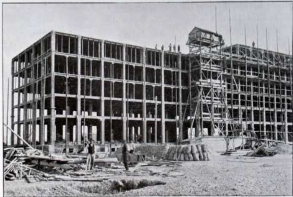
Abb. 33. Lagerhaus in Strassburg während des Baues.
