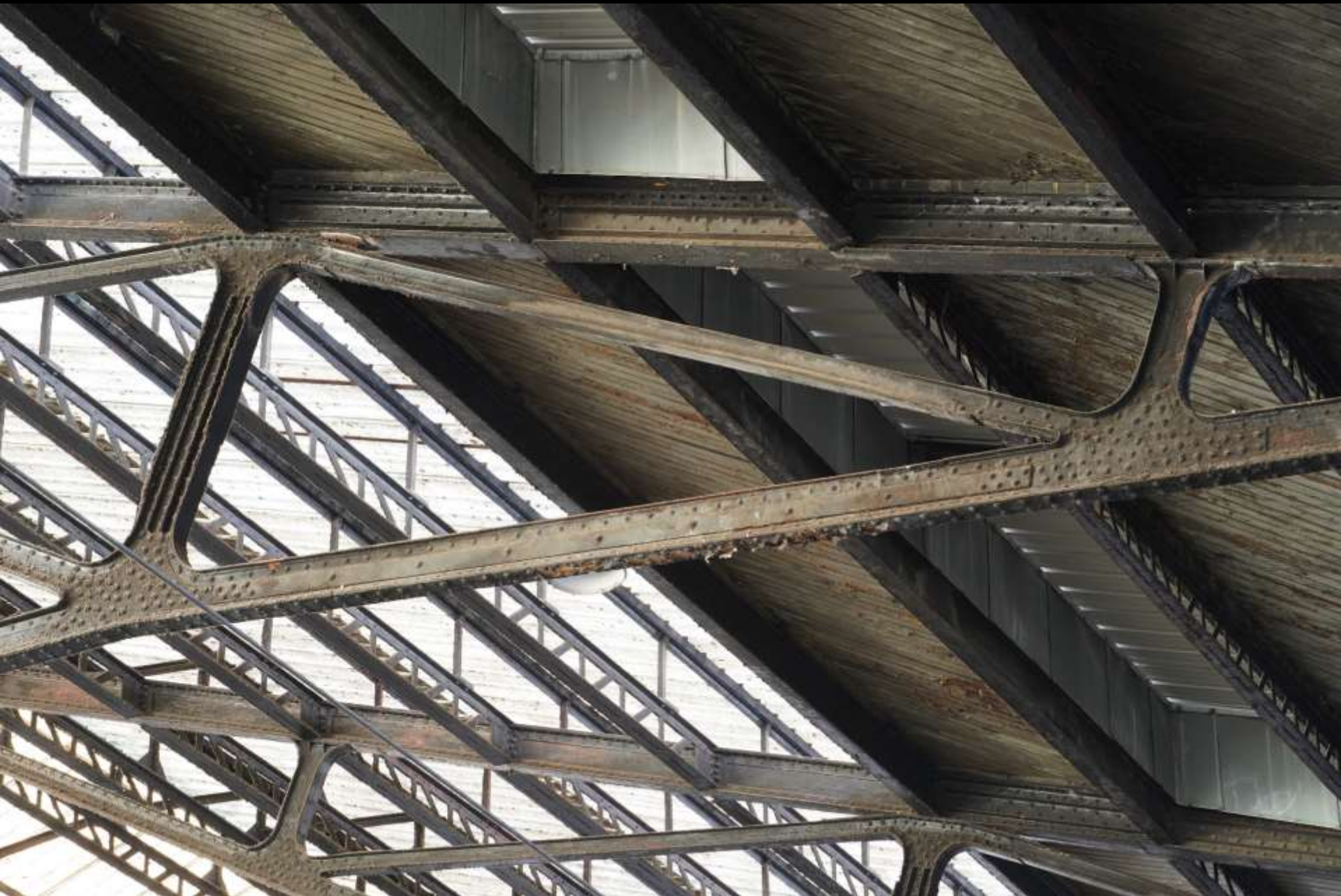
Transformation: Paris, Gare Saint-Lazare (1851-53). Genietetete Blechfachwerke in Art des Polonceau-Systems
