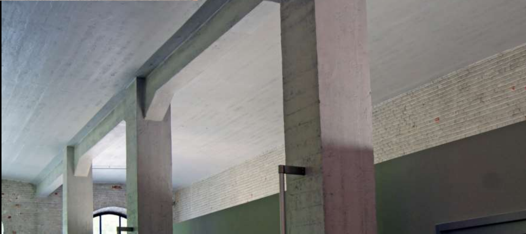
Hennebique: System Stütze-Unterzug-Platte Lagerhaus Thurn & Taxis, Brüssel (1904-06)
