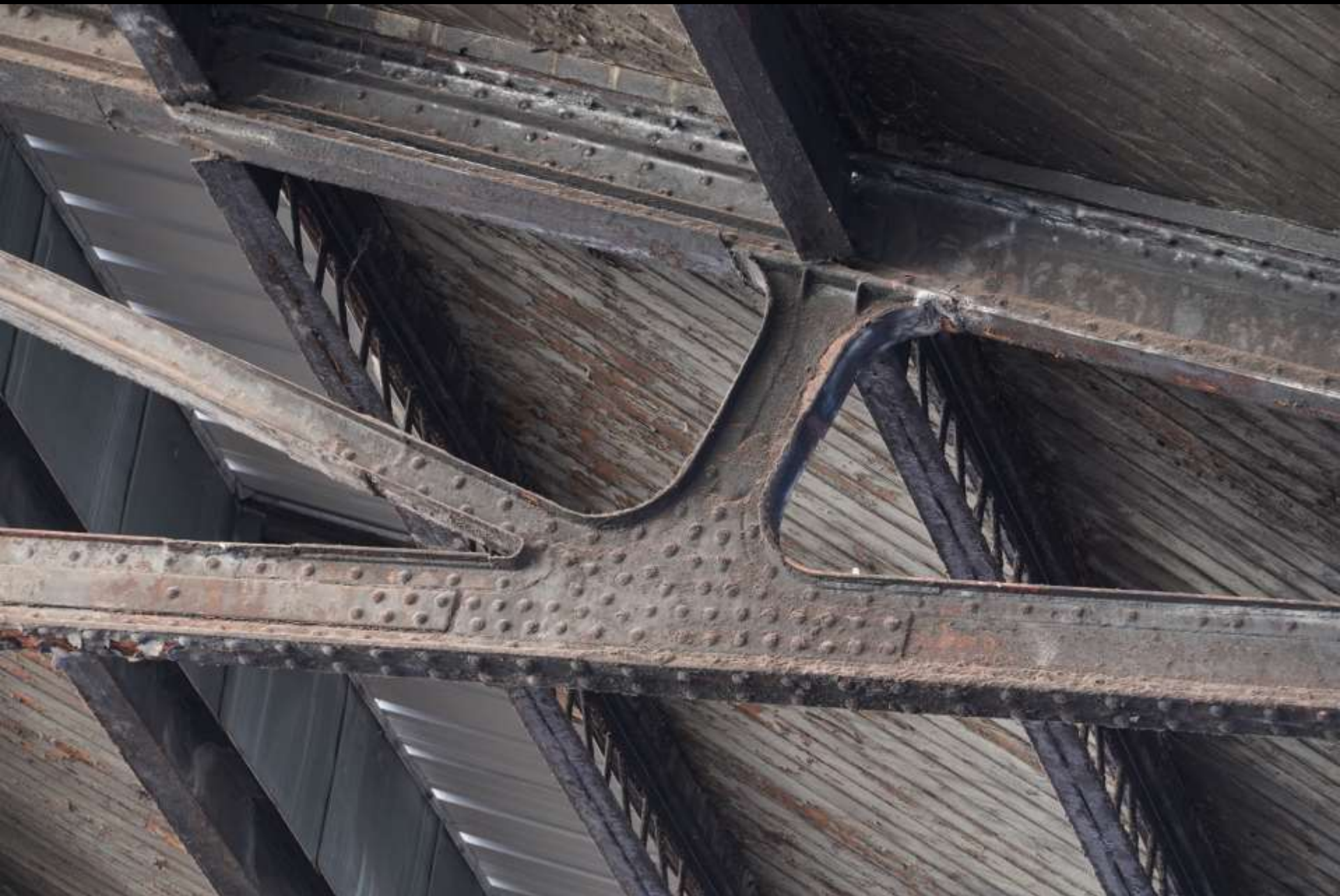
Transformation: Paris, Gare Saint-Lazare (1851-53). Genietete Blechfachwerke in Art des Polonceau-Systems
