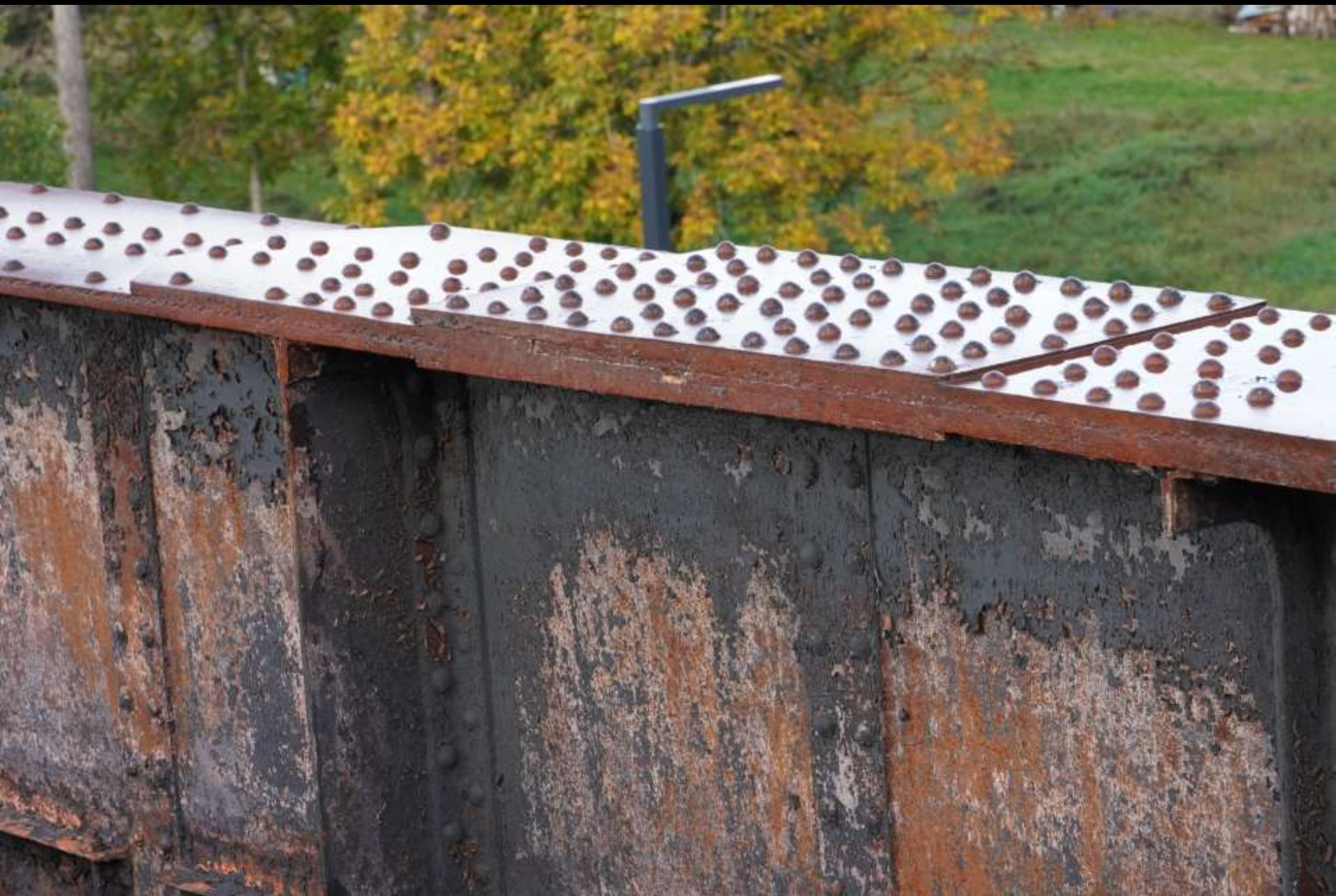
Moulins, „Pont Noir“ (1858). Verstärkung an einer Stütze
