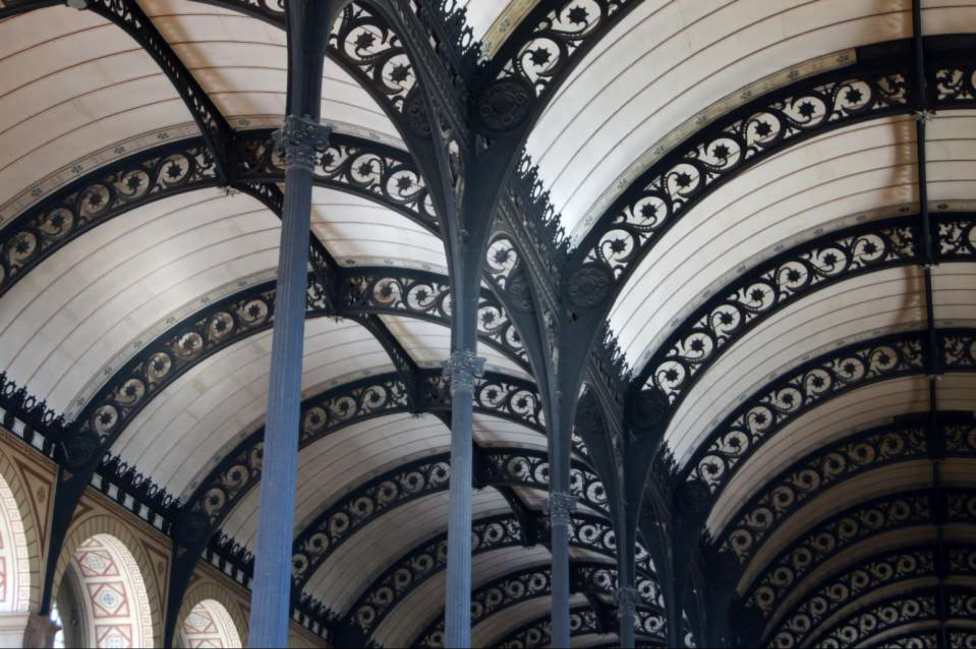
Paris, Bibliothèque Sainte-Geneviève (Henri Labrouste, 1850) Sichtbare Konstruktions Elemente in Gusseisen
