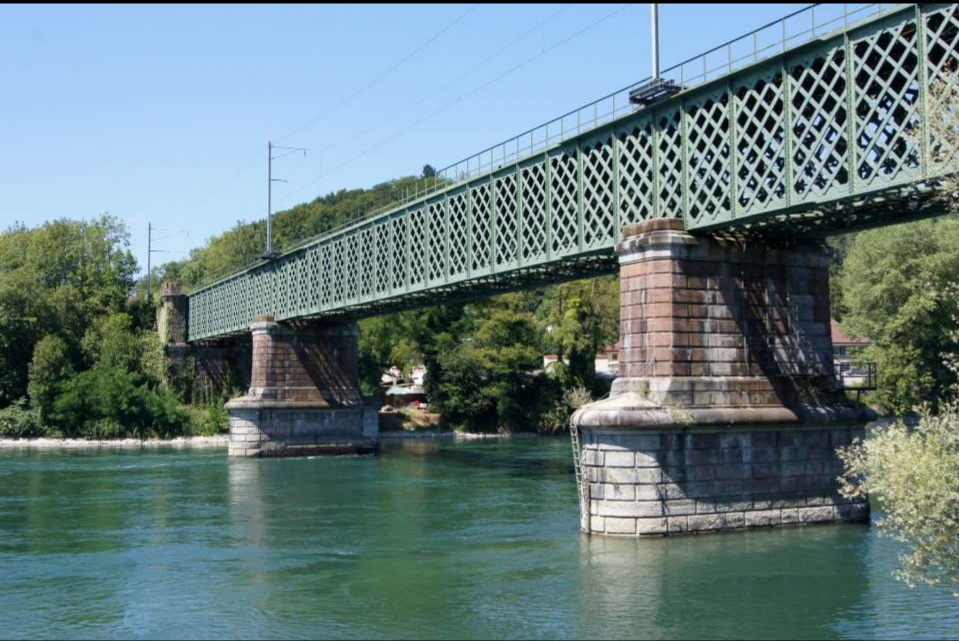
Koblenz (AG), Rheinbrücke (Robert Gerwig, 1859). Erfolgsmodell Gitterträgerbrücke mit ausgesteifter Tragwand
