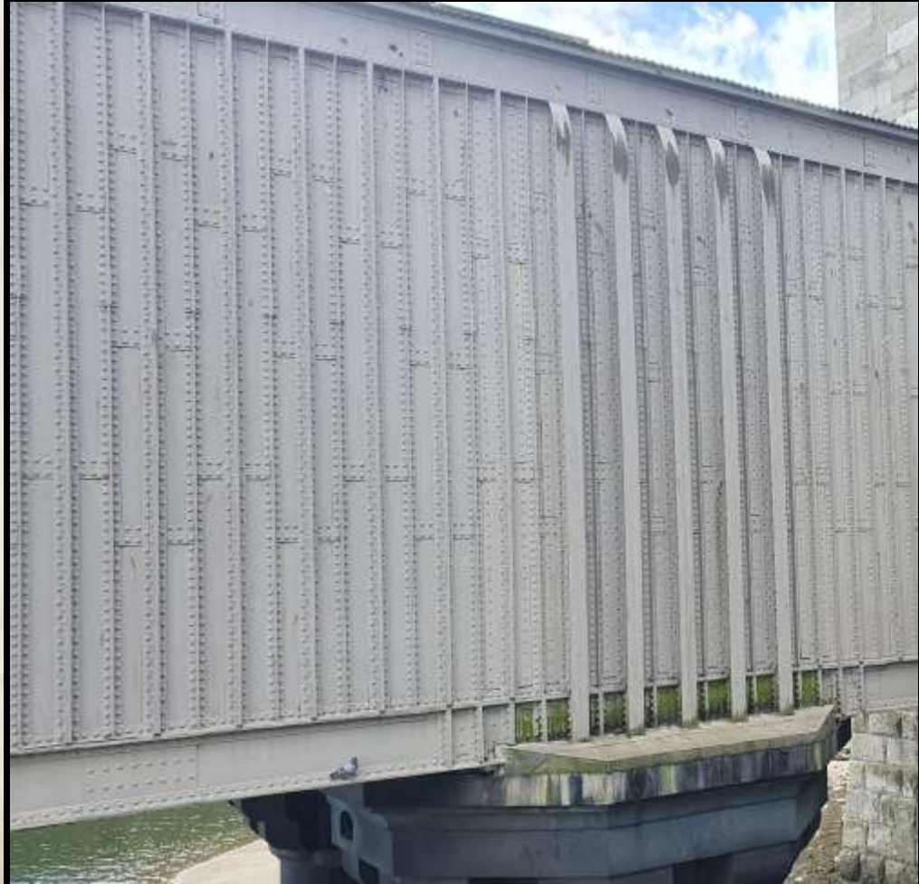
Konstruktion des Blechträgers als ausgesteifter Kasten (links: Britannia Bridge, Clark 1850; rechts: Conway Bridge, Foto: Monika Heim)
