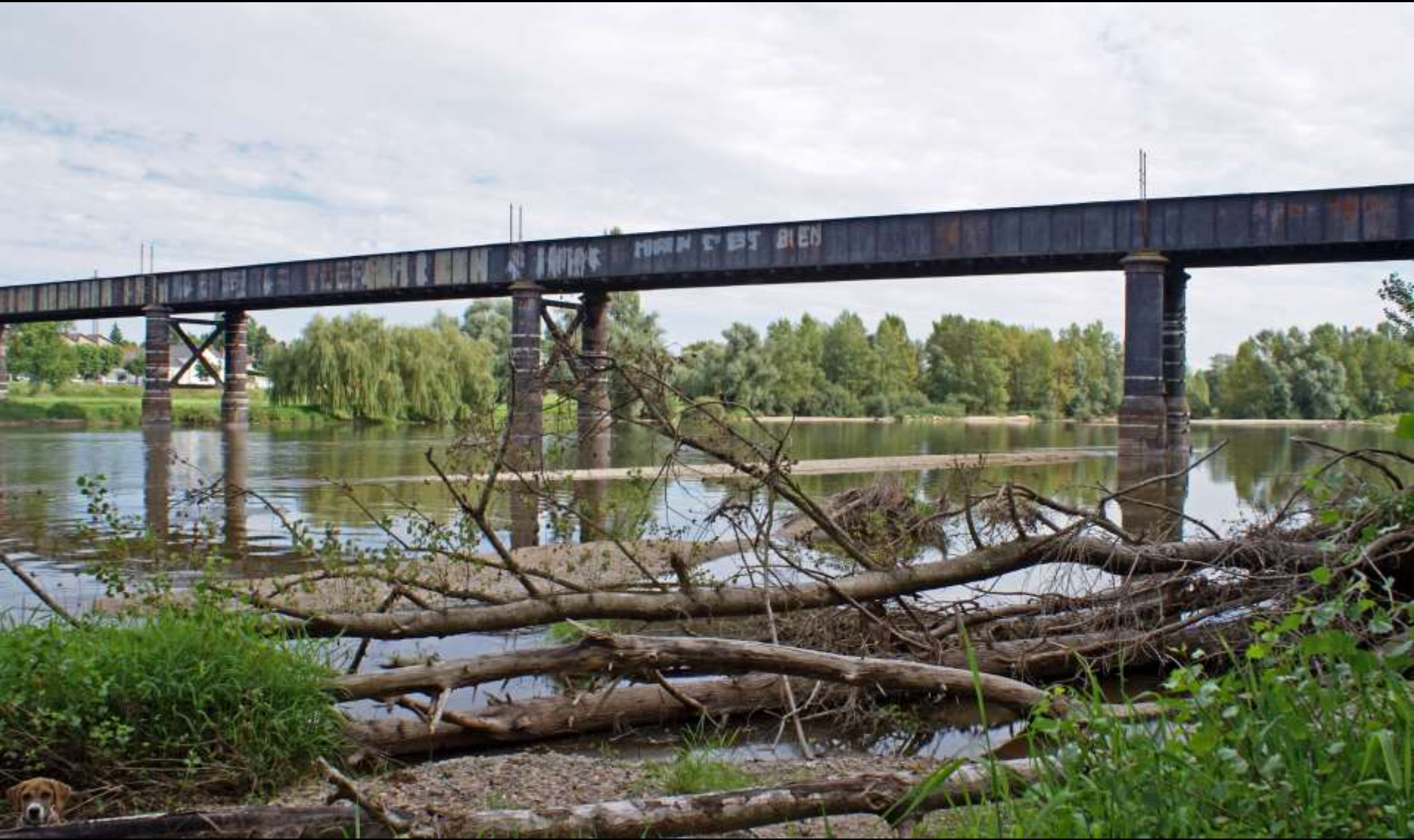
Moulins, „Pont Noir“ über die Allier (1858)
