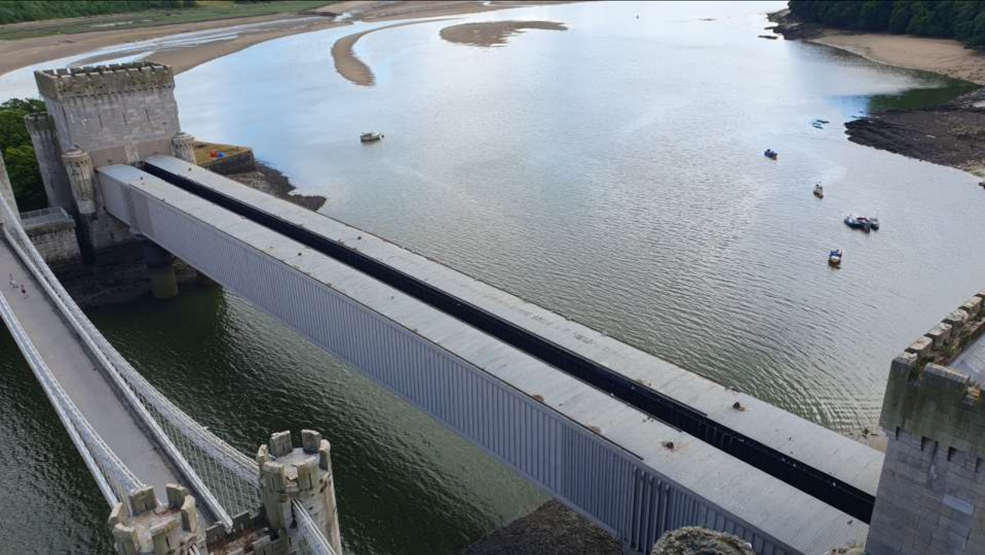
Conway Bridge, 1849. Länge der Röhren 129 m. Robert Stephenson, William Fairbairn (Foto: Monika Heim)
