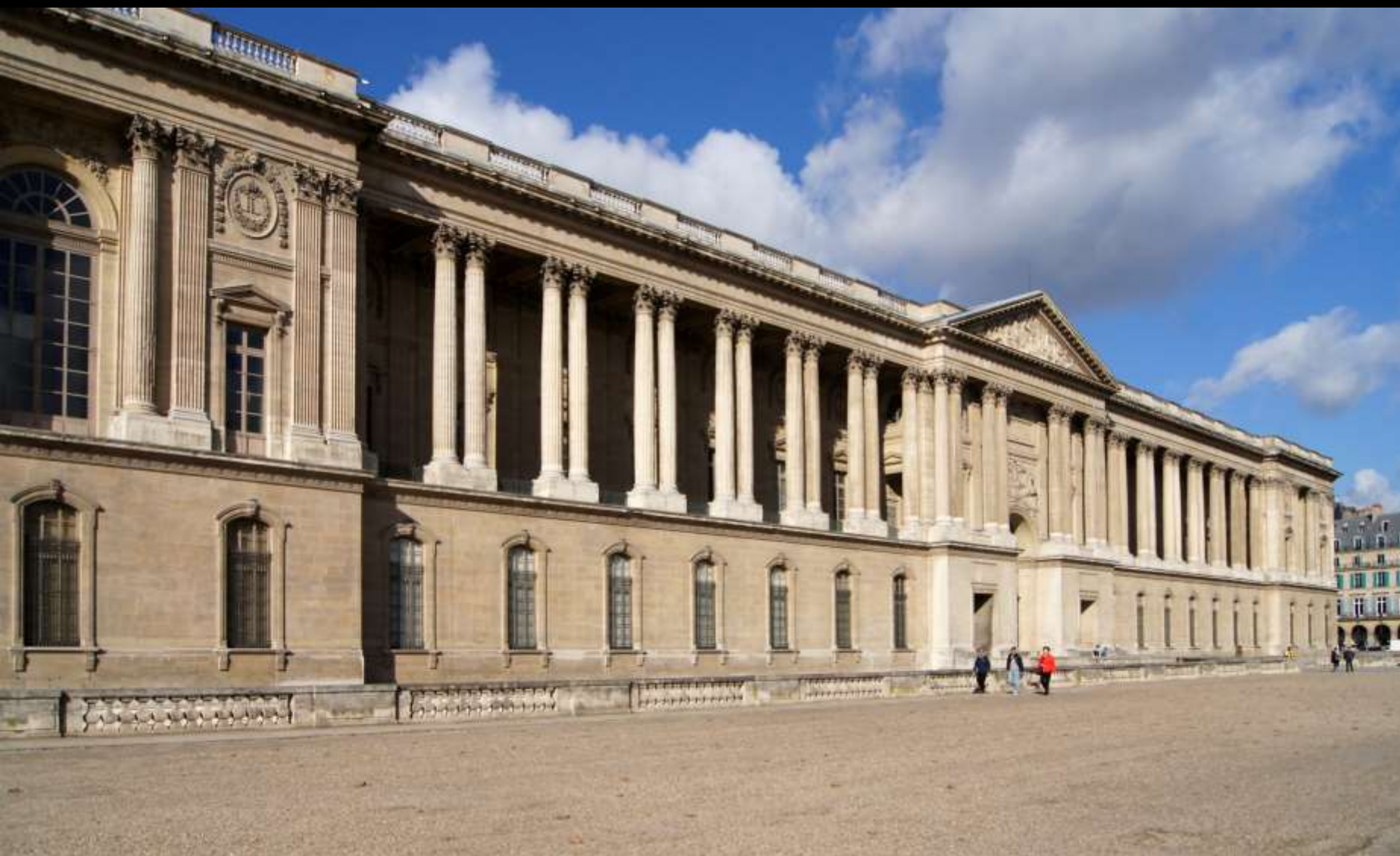
Ostfassade mit Graben
