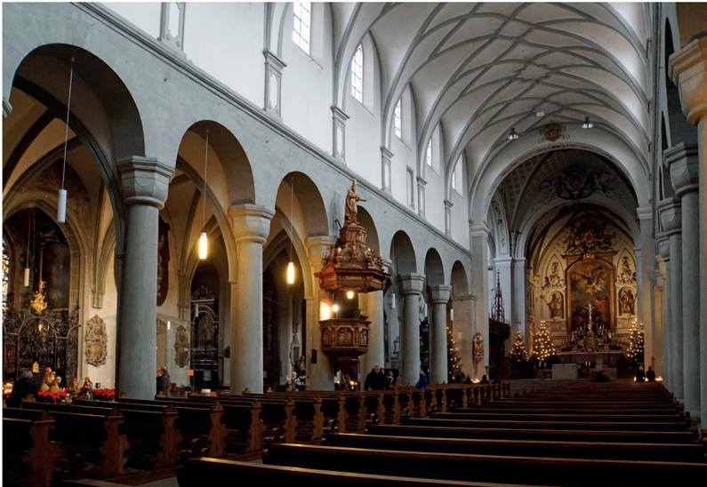
**Abb. 7:** Baugeschichte ablesbar: Säulen des 10. Jh. in einem Bau des 11. Jh. mit Gewölbe von 1680 und Umgestaltung des Chores 1776, Münster Konstanze (S. Holzer)
