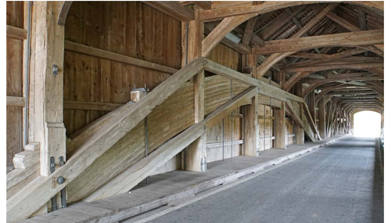
Reussbrücke Sins-Hünenberg (Foto: Stefan M. Holzer, 2017)
