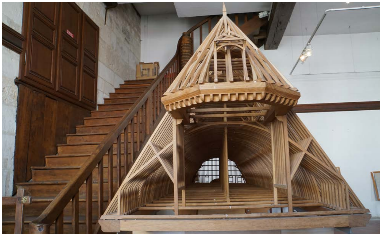
Dachwerksmodell Tonnerre (Foto: Stefan M. Holzer)
