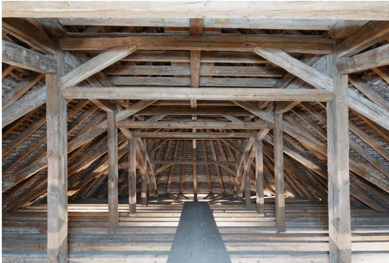
Dachwerk der reformierten Kirche Horgen ZH, 1780 – 1782 erbaut von Johann Jakob Haltiner. (Foto: Jasmin Schäfer, 2018)
