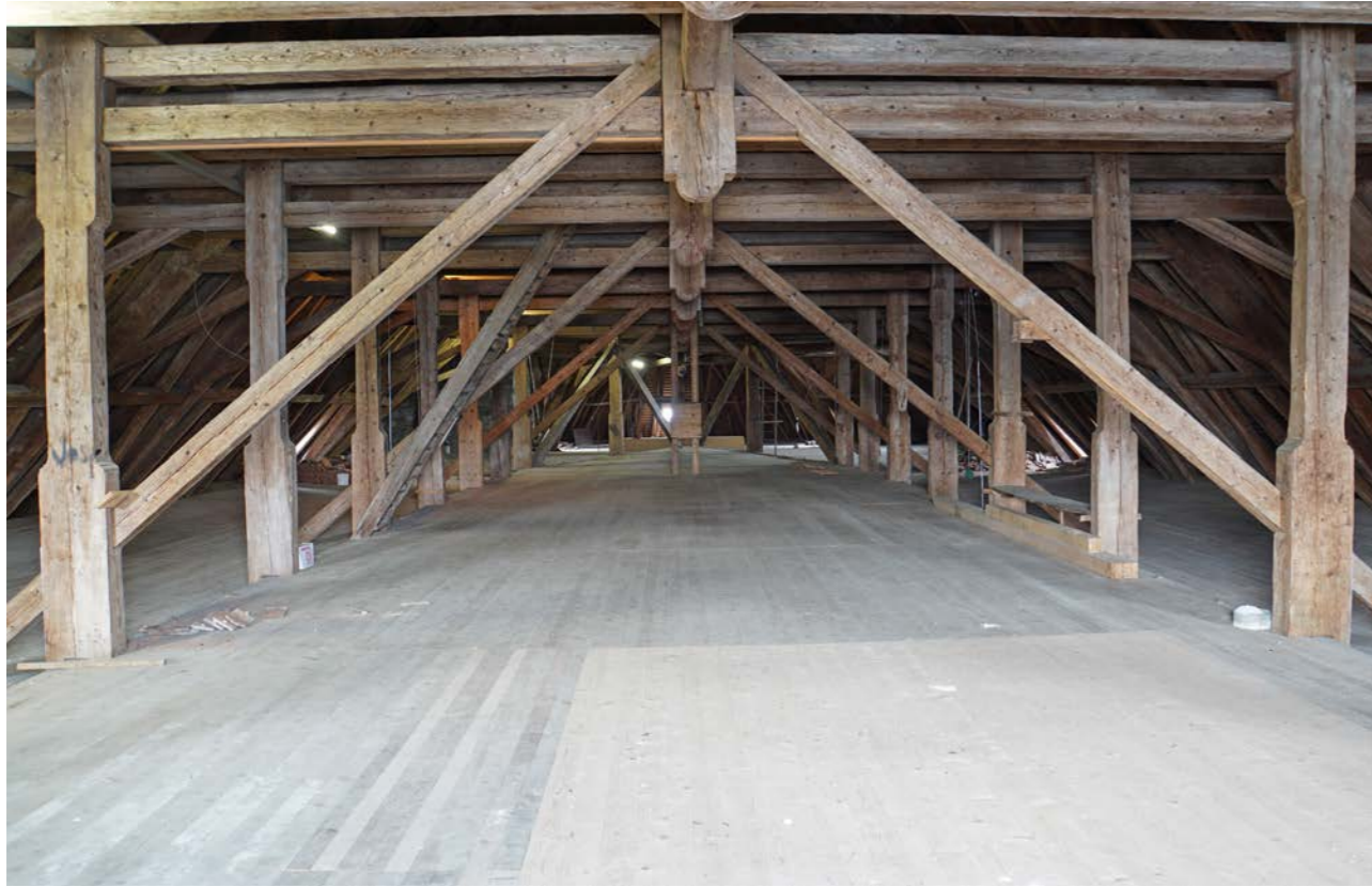
Schüpfheim LU, Pfarrkirche St. Johannes und Paul, Aufrichte November 1806, Weihe 1822, Übersicht über das Dachwerk des Langhauses von Westen. (Foto: Martin Gantner)
