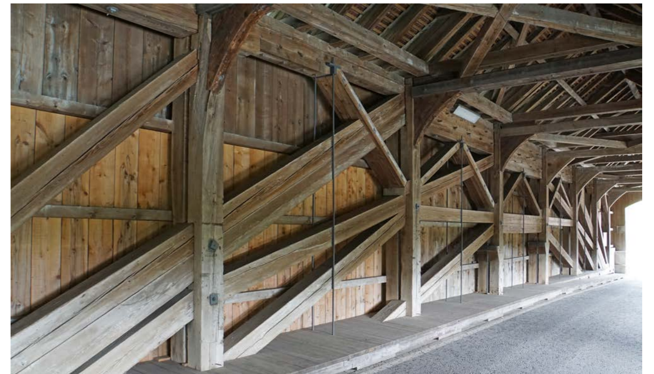
Reussbrücke Sins-Hünenberg (Foto: Stefan M. Holzer, 2017)
