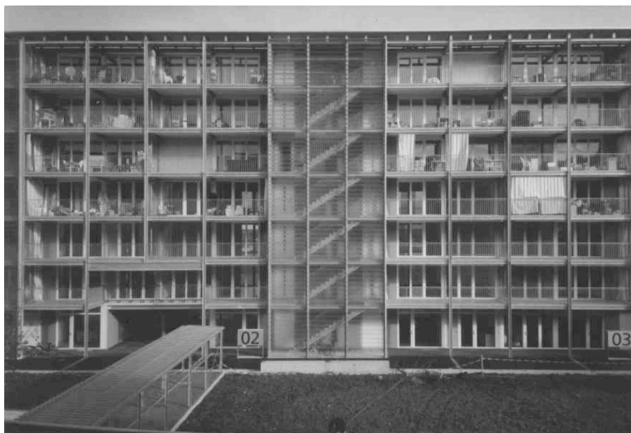
Abbildung 5: Fassade zum Hof
