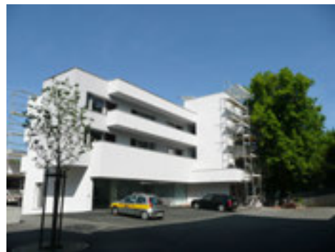
Abb. 4 Siedlung Ost, Eingang Spitex und Ambulatorium
