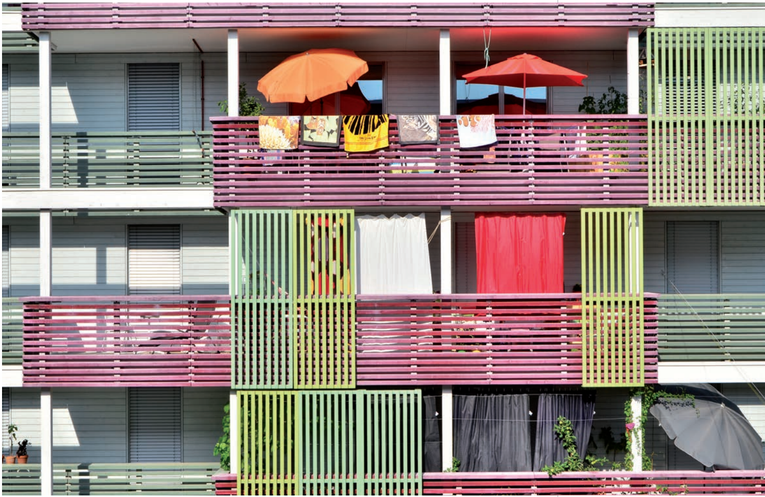
Fassade Mehr- Generationen-Haus Giesserei, Winterthur (Foto: Kurt Lampart)
