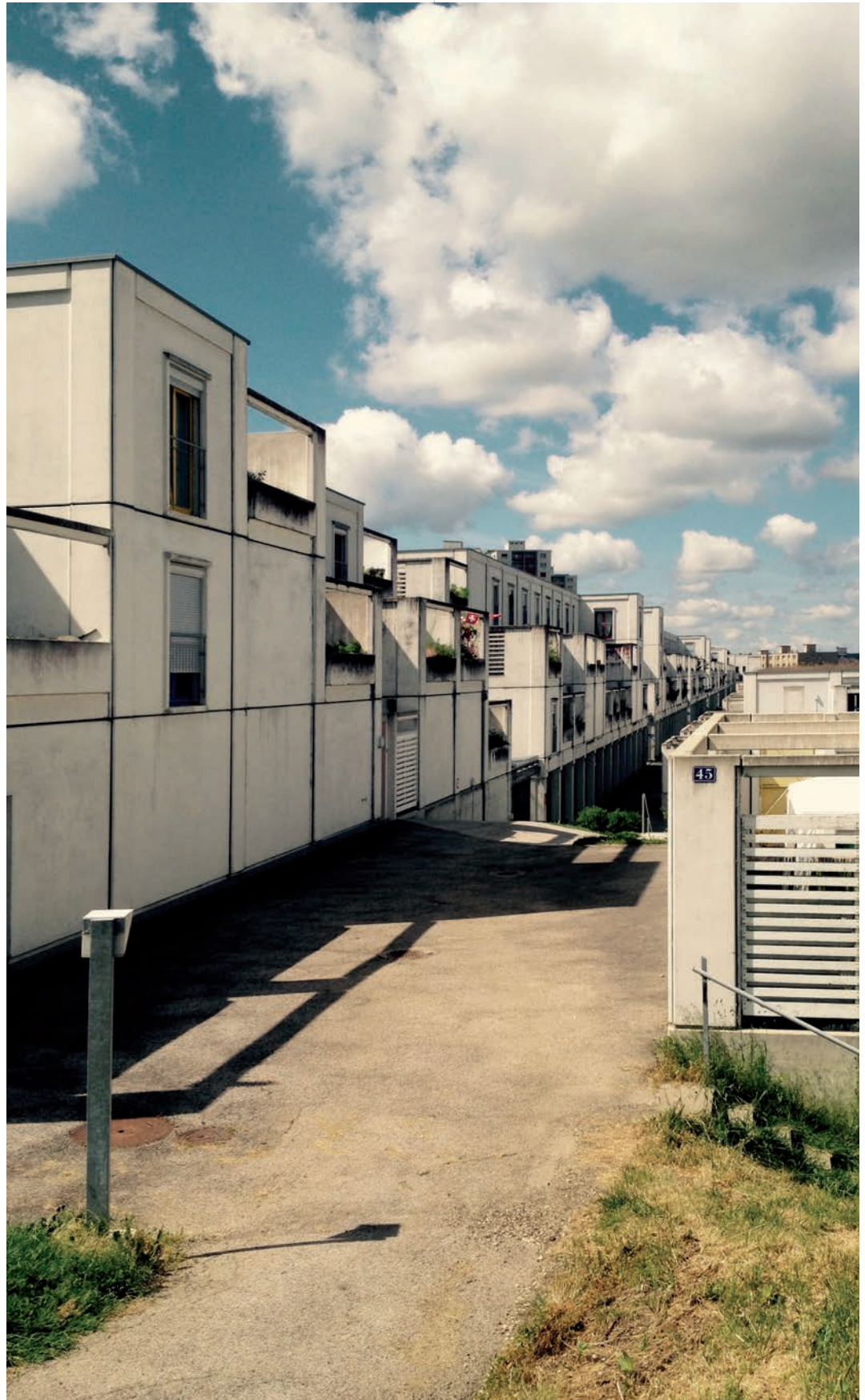
Blick auf die Fußgänger- achse, Siedlung Esplanade (Foto: Angela Birrer)
