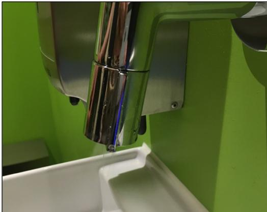
**Abbildung 6:** Wasser- und energiesparender Wasserhahn (Quelle: Forschungsteam TU Berlin)
