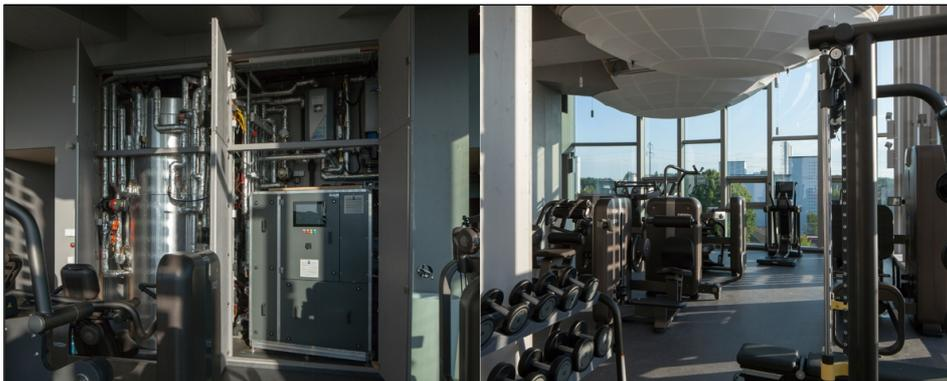
**Abbildung 5:** Hochtemperatur-CO<sub>2</sub>-Wärmepumpe (links) Fitness- und Wellnessbereich (Quelle: emp.ch)
