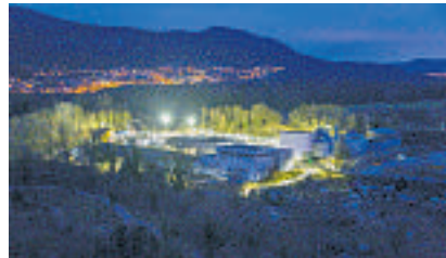
AVAU-Areal mit und ohne Arealbeleuchtung
