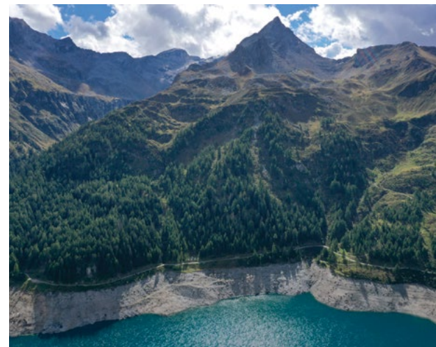
Photo: IGT, D-BAUG
