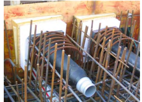
Bild 2: versetzte Ankerplatten
