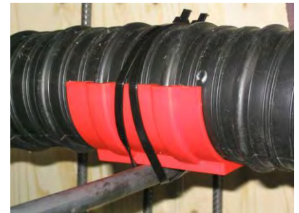
Bild 5: Spanngliedunterstützung mit Schutzschale
