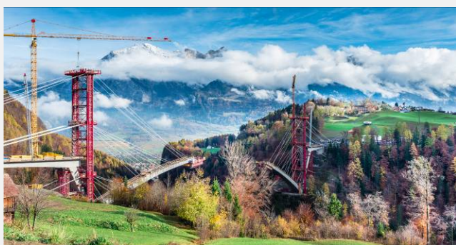
Taminabrücke: Visualisierung und aktueller Bauzustand
