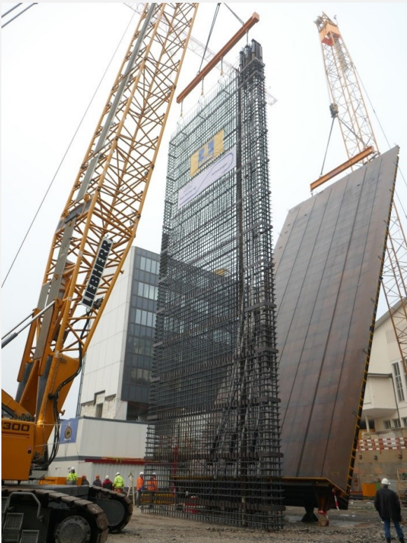
Bewehrungskorb Schlitzwandscheibe mit Vorspannkabeln (Quelle: Implenia Schweiz AG und Bauer Spezialtiefbau Schweiz AG)
