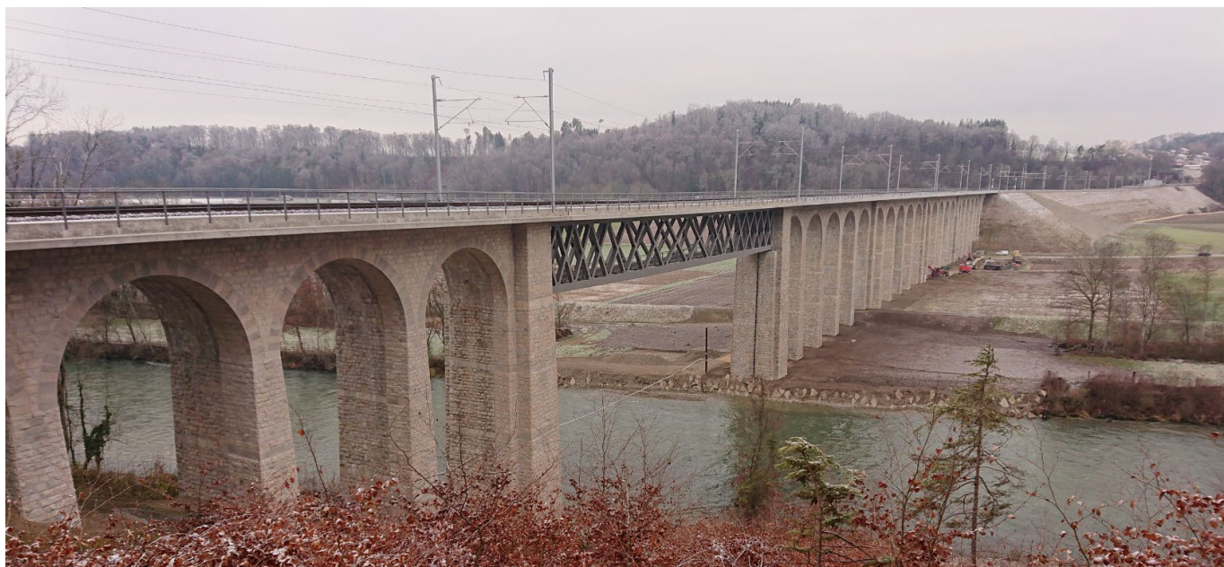
Saaneviadukt nach Doppelspurausbau
