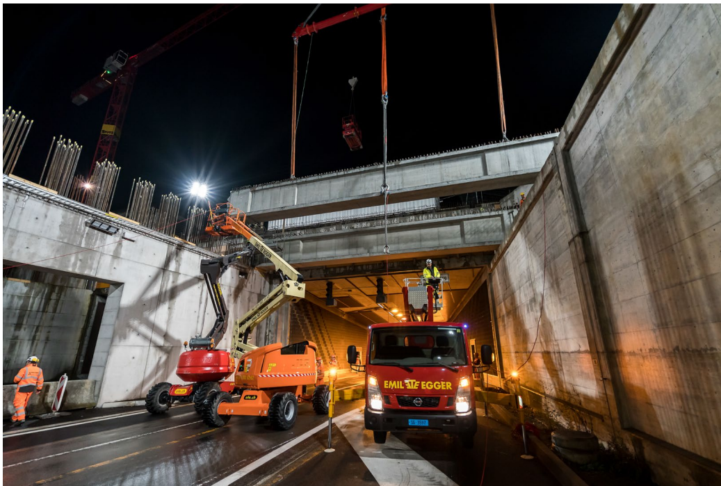
Baustelle OLMA + Betonträger, © foto-huwi
