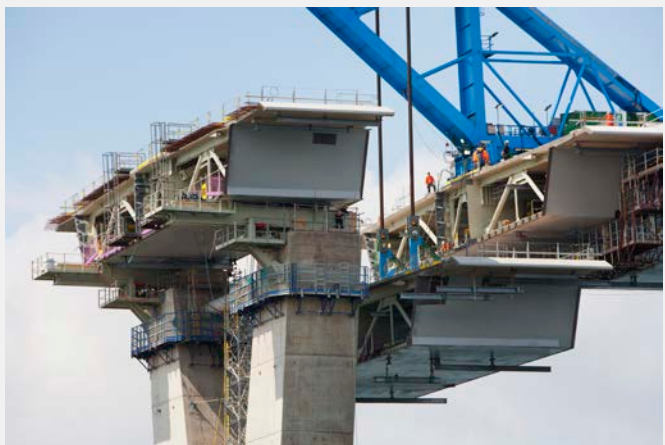
Bauzustand der drei Pylone (oben) und Freivorbau kurz vor dem ersten Pfeiler der Vorlandbrücke (unten)
