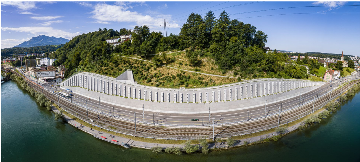
Stützmauer Reussthal, © Emch+Berger WSB AG
