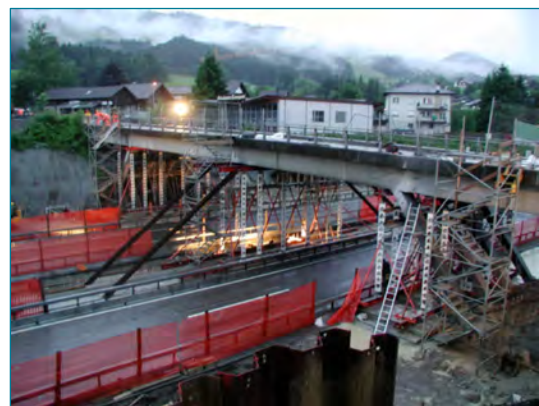
Abb. 19 Abbruch der Überführung Burggasse bei Altdorf SZ durch Zersägen auf Hilfsjochen
