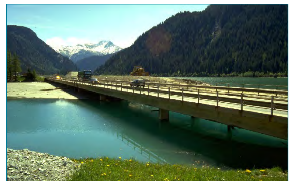
Abb. 12 Steilerbachbrücke Sufers GR
