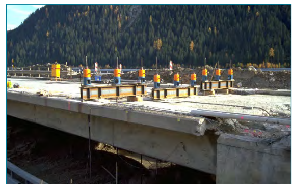
Abb. 13 Erdanker mit hydraulischen Pressen
