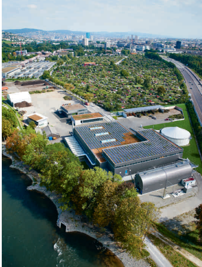
Synergien nutzen: Die Biogas Zürich AG und der Logistikstützpunkt Werdhölzli.
