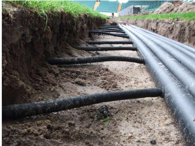
**Abbildung 9:** Unterflurbewässerung in einem Fussballstadion [27]
