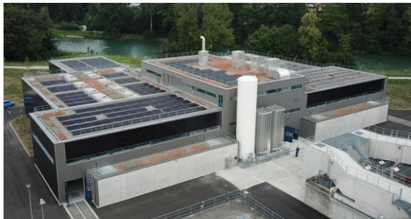
Abbildung 1: Die Ozonungsanlage im Werdhölzli
