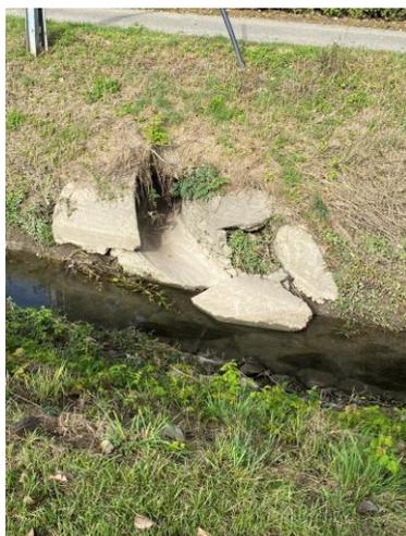
**Abbildung 1: Einleitung des Regenüberlaufbeckens in den Bipperkanal.**
