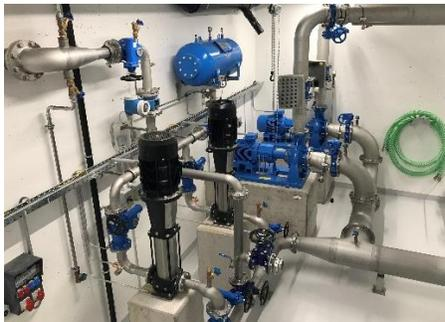
**Abbildung 1: Pumpen der Grundwasser-Aufbereitungsanlage**
