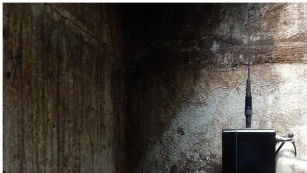
Abbildung 1: Messstelle im Kanalnetz. Quelle: eawag.ch
