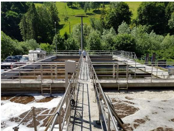
Abbildung 1: Belüfteter Belebtschlammreaktor.
