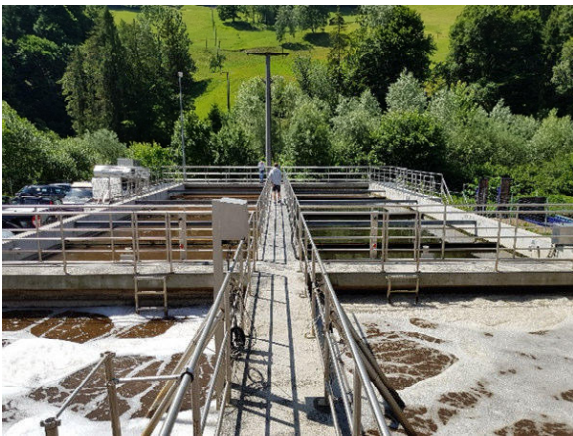
Abbildung 1: Belüftungsbecken der biologischen Stufe.
