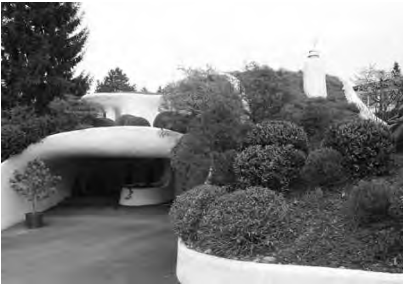
Abbildung 26 In das Gelände integriertes Haus – wo endet der gewachsene Boden?
