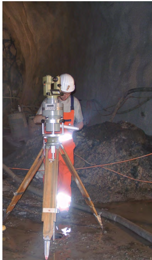
Dante Salvini bei Vermessungen im Tunnel
