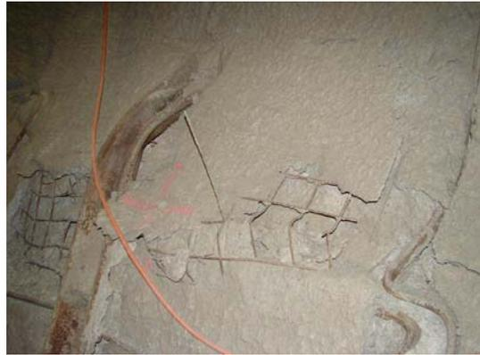
*Bild 6: Verformungen der eingebauten Ausbruchsicherung (Paramentbereich)*
