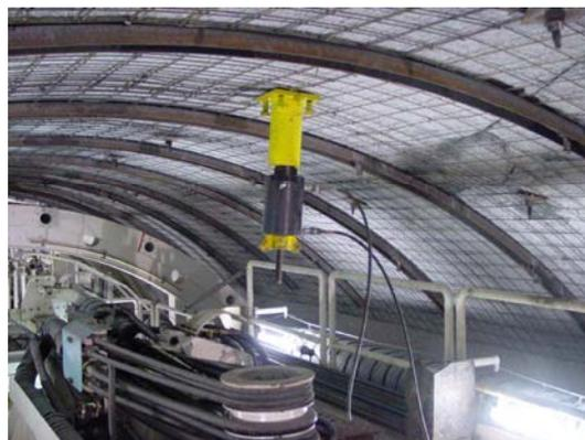
*Bild 3: Ausbruchsicherung im L1-Bereich bestehend aus Reibrohrankern, Bewehrungsnetzen und UNP-Teilbogen*
