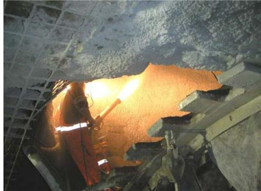
Bild 4: Durch Niederbruch entstandener Hohlraum
