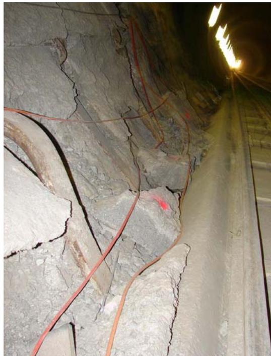
*Bild 7: Verformungen der eingebauten Ausbruchsicherung (Kämpferbereich)*
