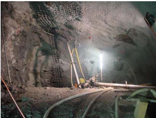
*Bild 8: Überfirstungsarbeiten zur Freilegung der verklemmten West-TBM*
