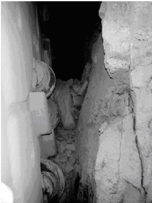
Figur 8. Situation an der Ortsbrust im TBM-Vortrieb Steg am 27.09.01 bei nicht zurück gezogenem Bohrkopf (Tm3862.7)
