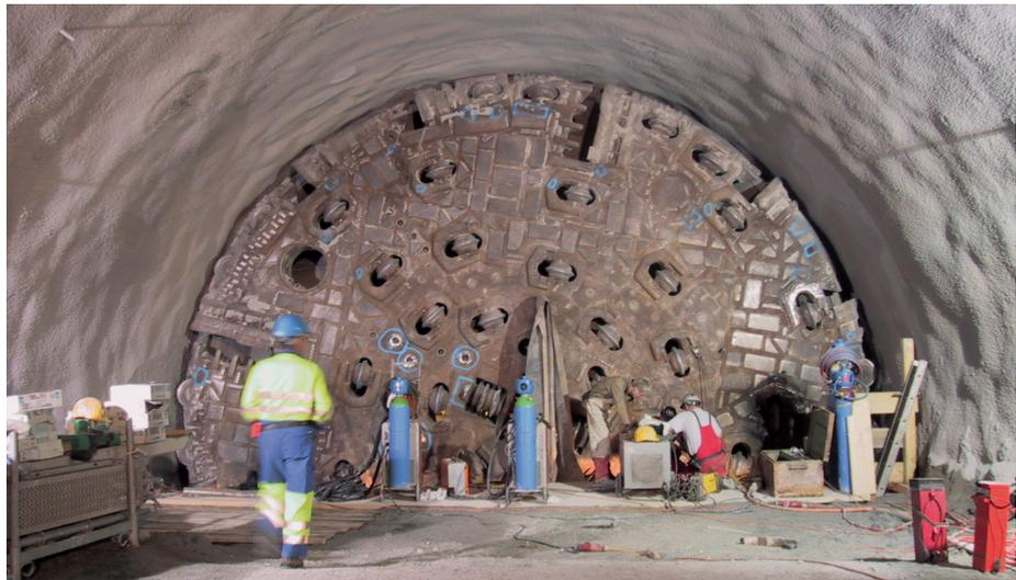
Zwischenrevision des Bohrkopfes der TBM West.
