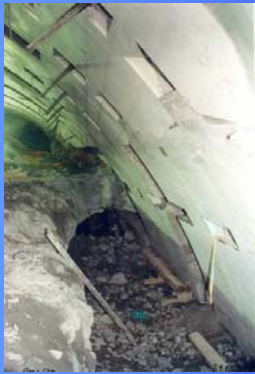
Ausbruch der Schulter und Gewölbschluss
