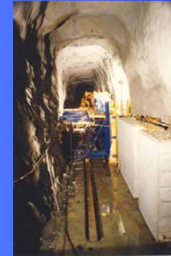
Ausbruch Paramentstollen und Betonieren der Paramente
