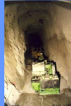
Ausbruch Paramentstollen und Betonieren der Paramente
