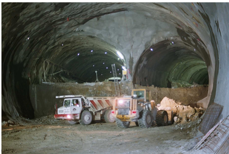
Bild 7 Vortrieb im Strosen-/Sohlbereich (Sequenzen 6a/6b).
