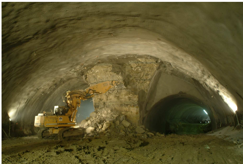
Bild 6 Abbruch des Kalottenkerns (Sequenz 5).
