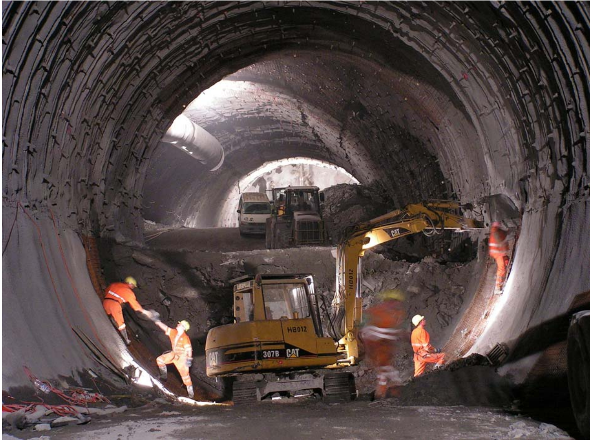
Bild 3 Tunnelwechsel Süd, Blick in Richtung TVOS(2)
