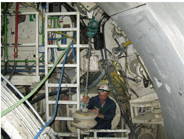
Abb. 39: Transport eines demontierten Rollenmeissels von der Materialschleuse zum Tübbingmagazin
