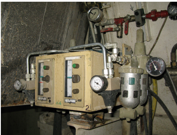
Abb. 13: Druckluftregelungsanlage Samson
