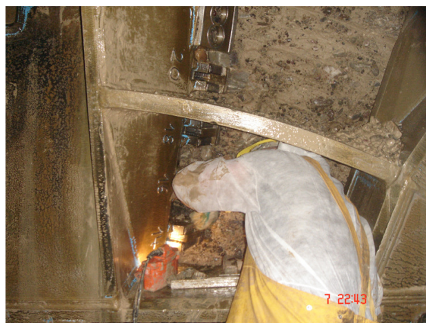
Abb. 35: Auswechseln von Schälmessern
