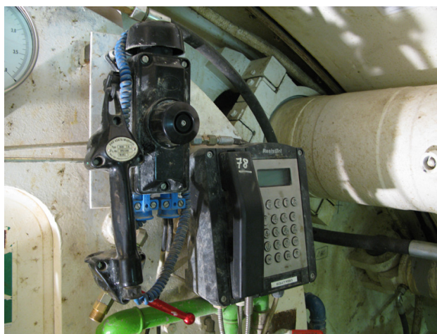
Abb. 28: Netzunabhängiges Notfalltelefon (links) und Festnetztelefon (rechts)
