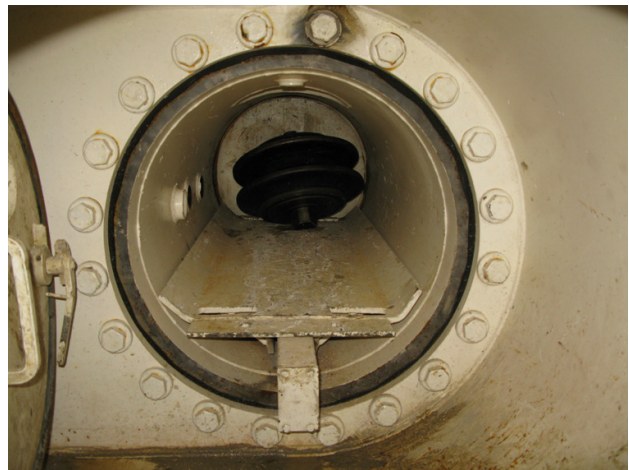
Abb. 16: Rollenmeissel in der Materialschleuse
