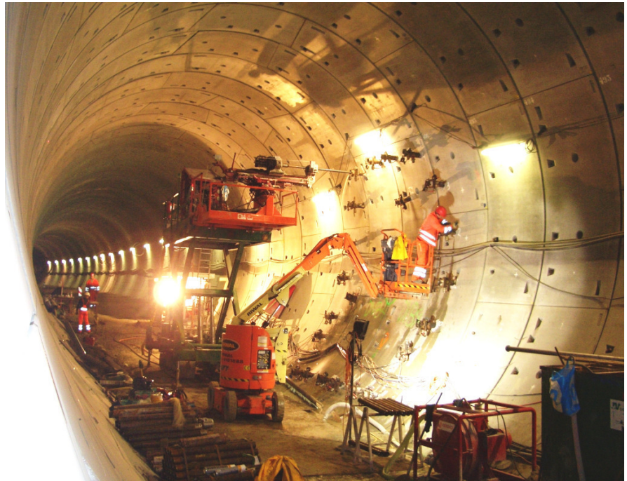
Bohrgerät auf Plattform vor dem Querschlag
