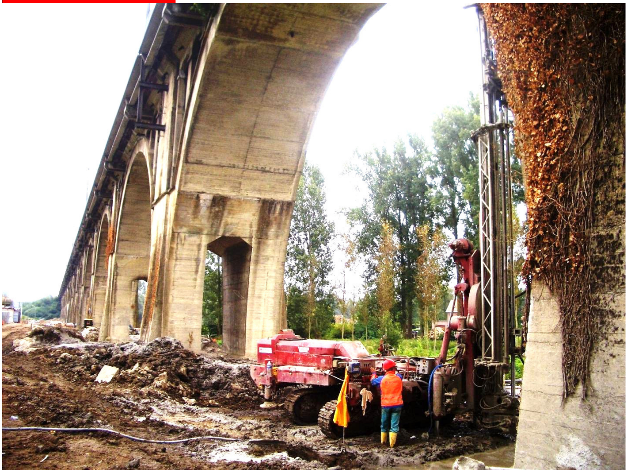
Bohrergerät Casagrande C8 in Arbeit
