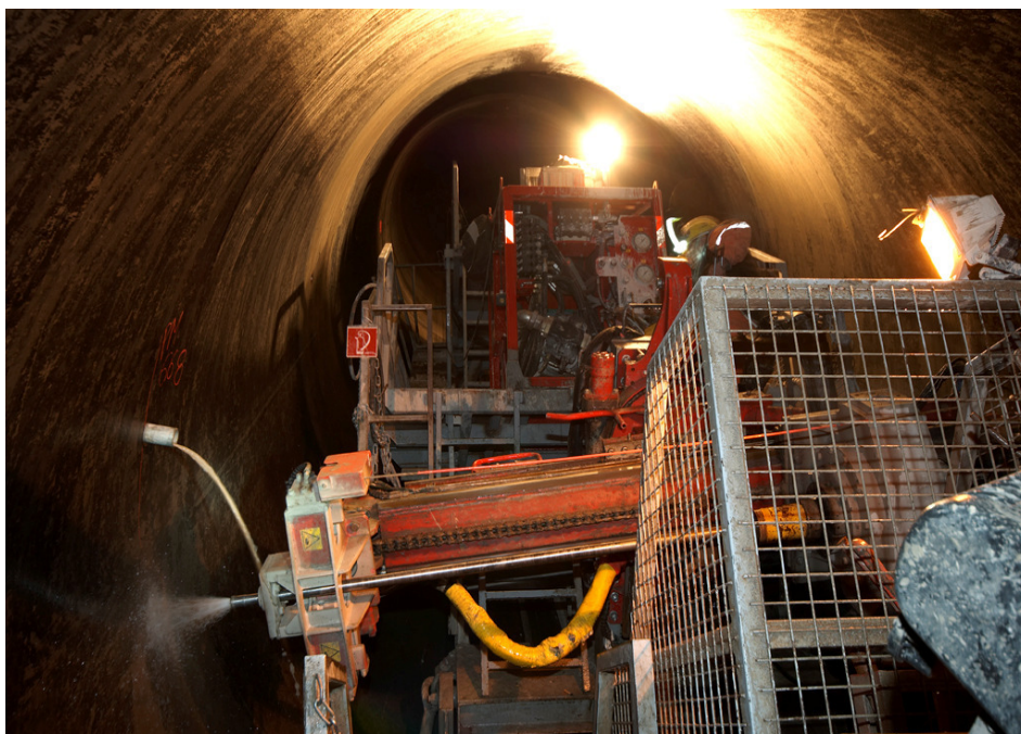
Bohrgerät im Druckstollen
