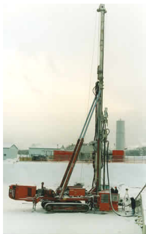
Bohrgerät RODIO SR 600
