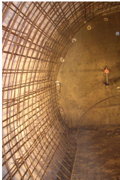
Querschlag ausgebrochen, mit gefrorenen Wänden
