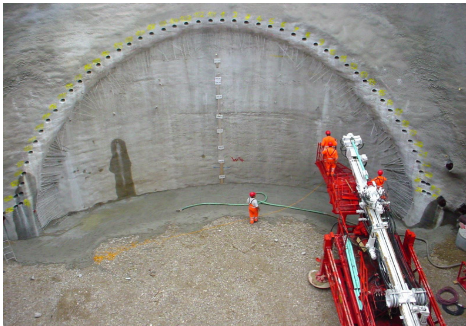
Bohrgerät RODIO SR 510 im Startschacht
