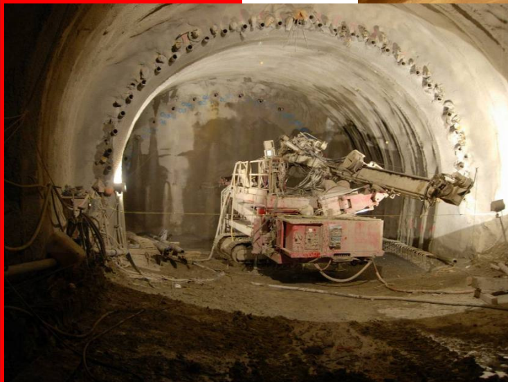
Bohrgerät RODIO SR510 im Tunnel Langgalerie Los 1300
