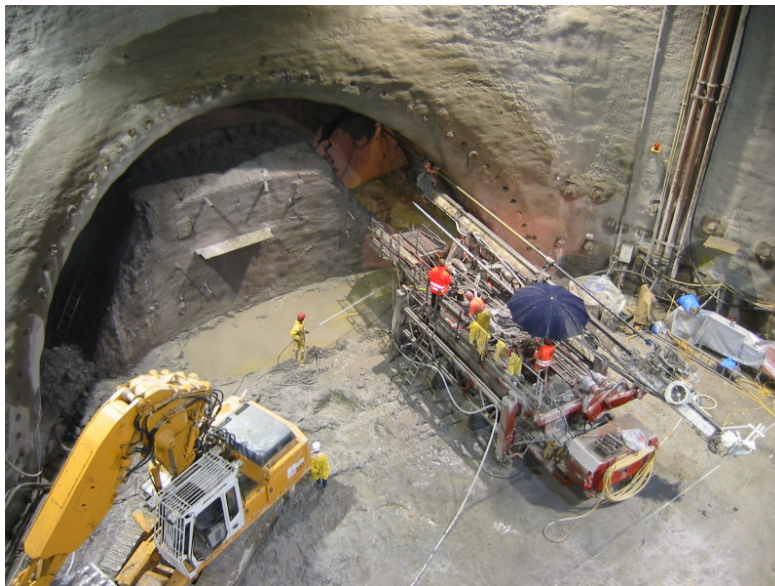
Bohrgerät RODIO SR 510 im Startschacht
