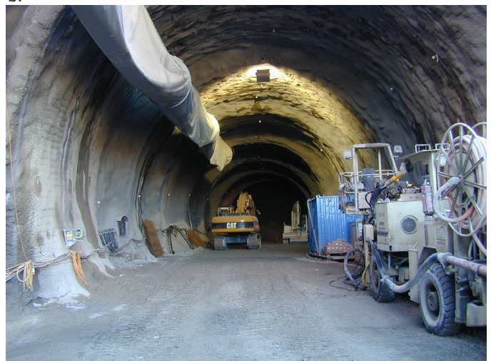
Fig. 3-4: a. Rohrschirm und Versetzen Ortsbrustanker, b. Ausbruchssicherung Sohle, c. Ausbruch fertiggestellt, prov. Aufschüttung
