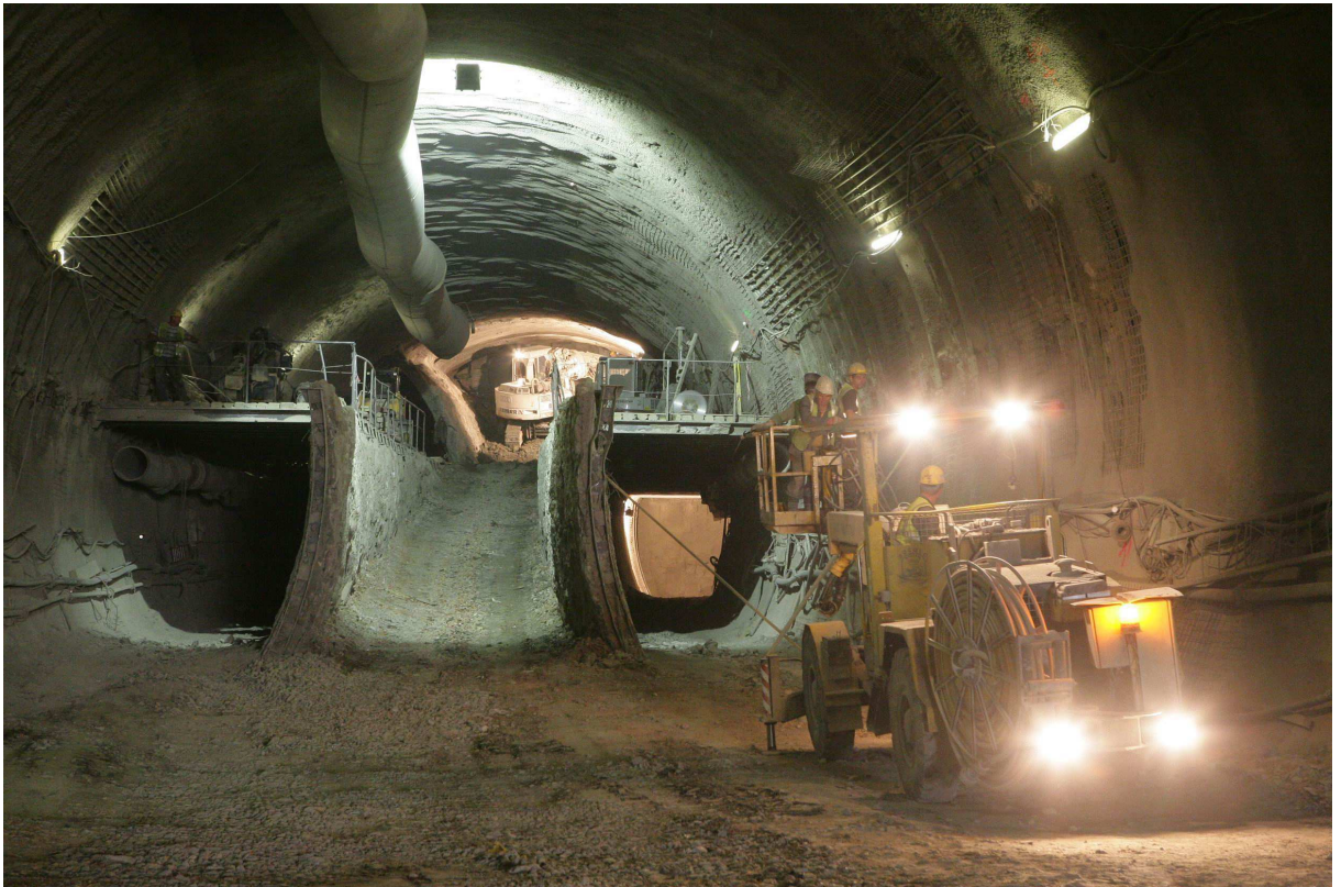
Bild 5 : Vortrieb mit geteiltem Ausbruch
