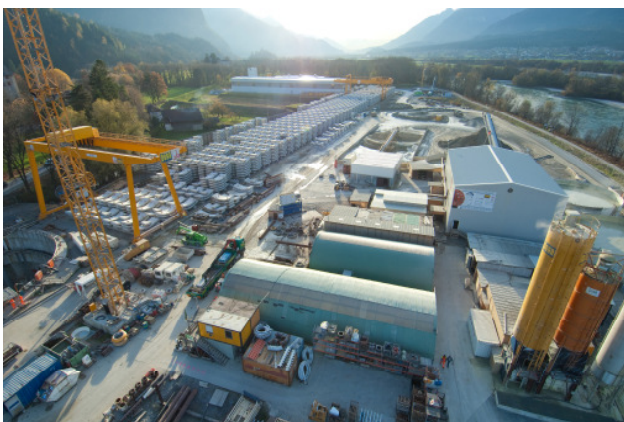
Abb.4: BE-Fläche, v.l.n.r.: Startschacht, Portalkran, Tübbinglagerfläche, Tübbingproduktionshalle, Werkstatt- und Magazinhallen, Trafostation, Zentrifugen, Separation, Austragsfläche, Bentonitmischanlage Arge H3-4
