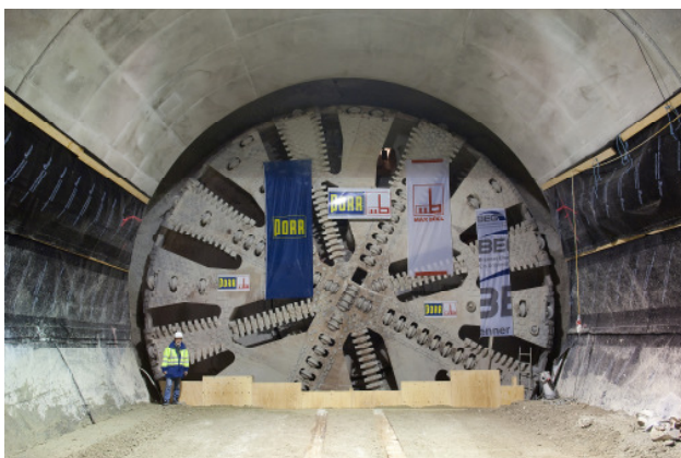
Abbildung 13: Schneidrad in Endposition nach Räumung des Stützkeiles
