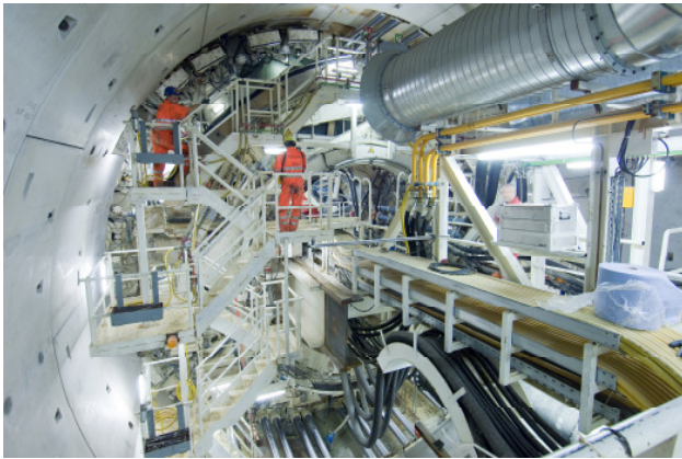
Abb.8: Blick auf die TVM während dem Versetzen eines Tübingensteines
