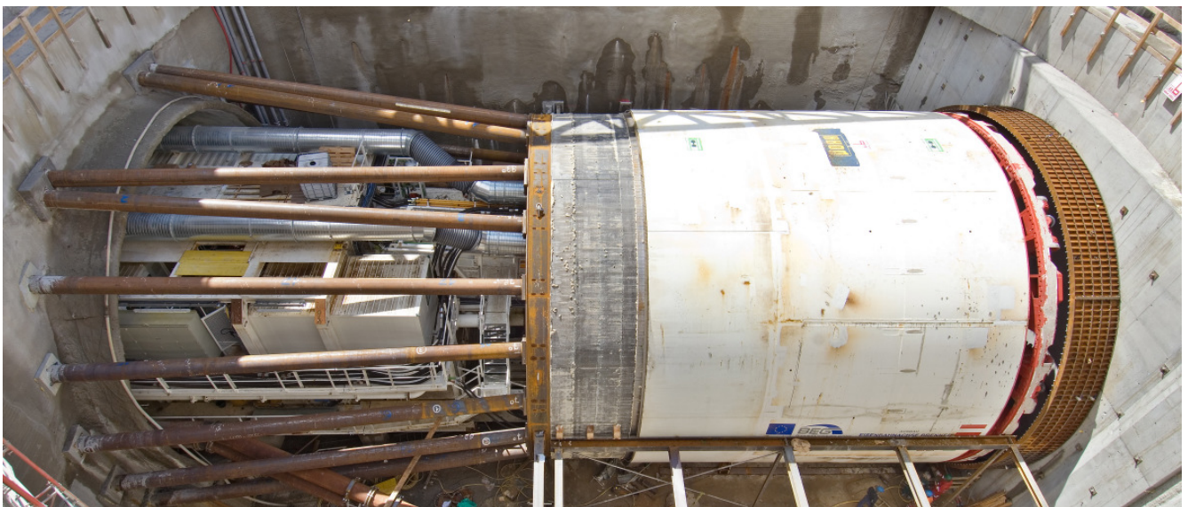
Abb.7: Fertig montierte TVM kurz vor dem Andrehen
