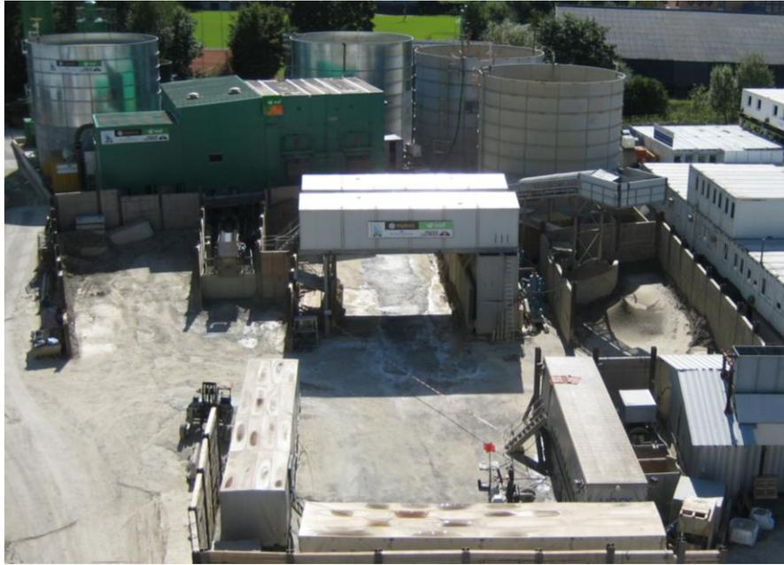
Bild 7 : Separierung mit Kammerfilterpressen
