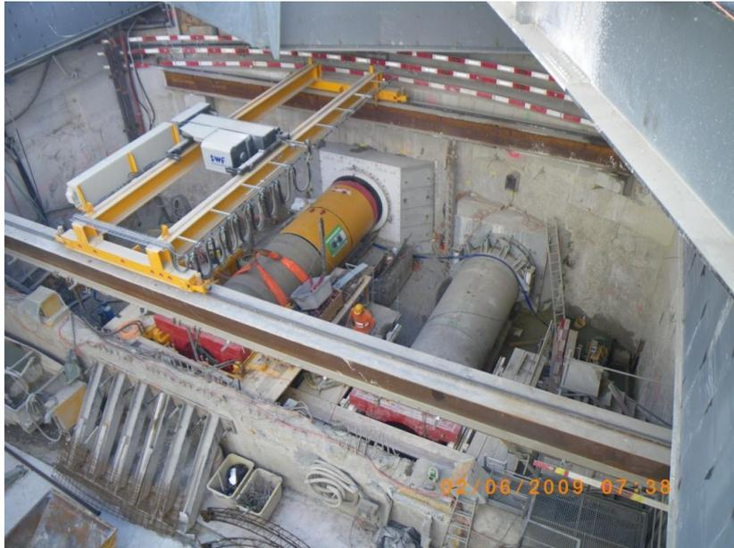
Bild 11 : Vortriebsinstallation Grossrohrschirm im Schacht Südtrakt
