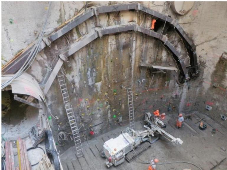
Bild 16 : Ansicht der Injektionsbohrungen des Dichtblockes
