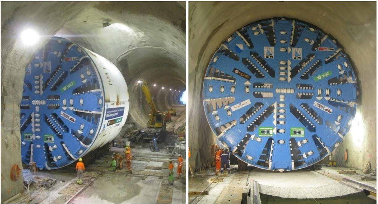
Bild 5 : TBM – Quer- und Längsverschub in Startkaverne
