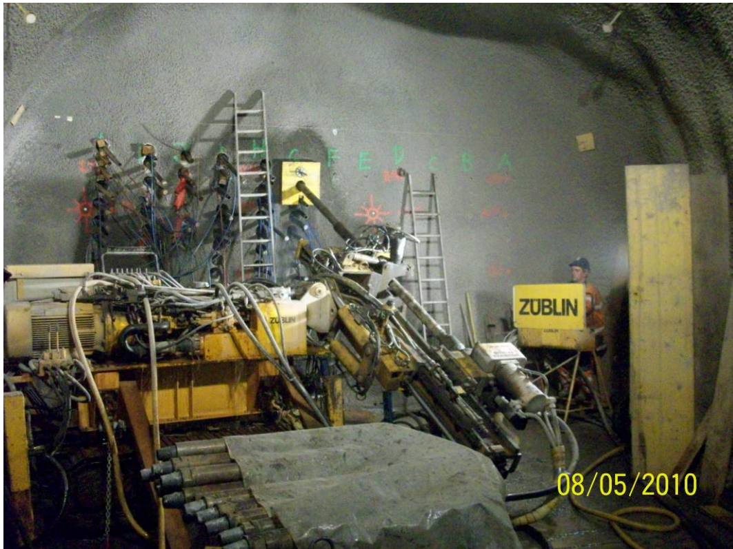
Bild 3: Bohrarbeiten in der Injektionsnische
