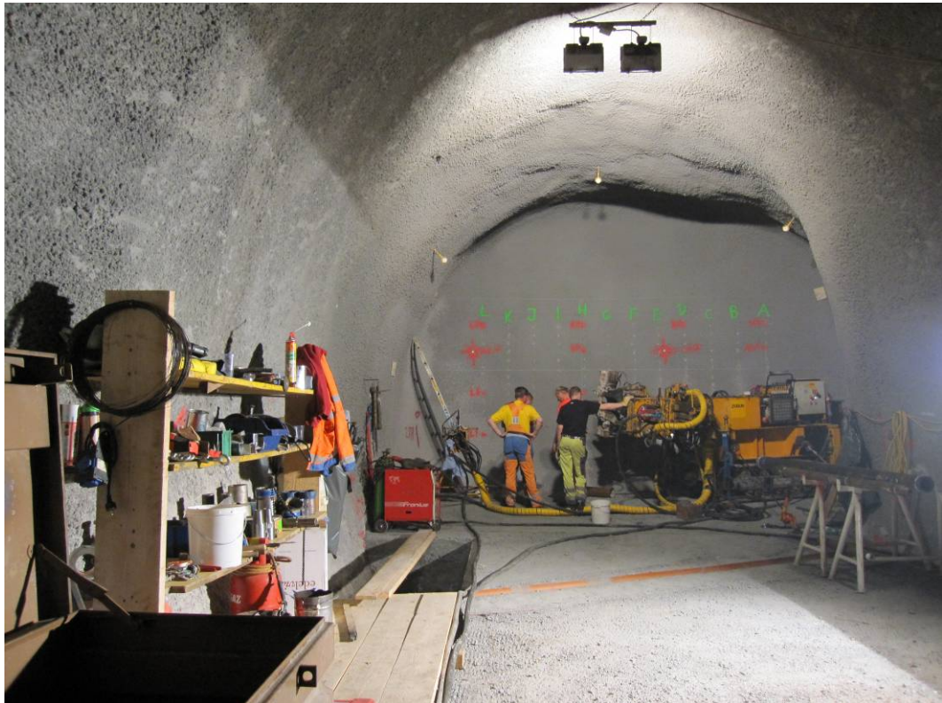
Bild 1: Injektionsnische vor Beginn der Bohrarbeiten
