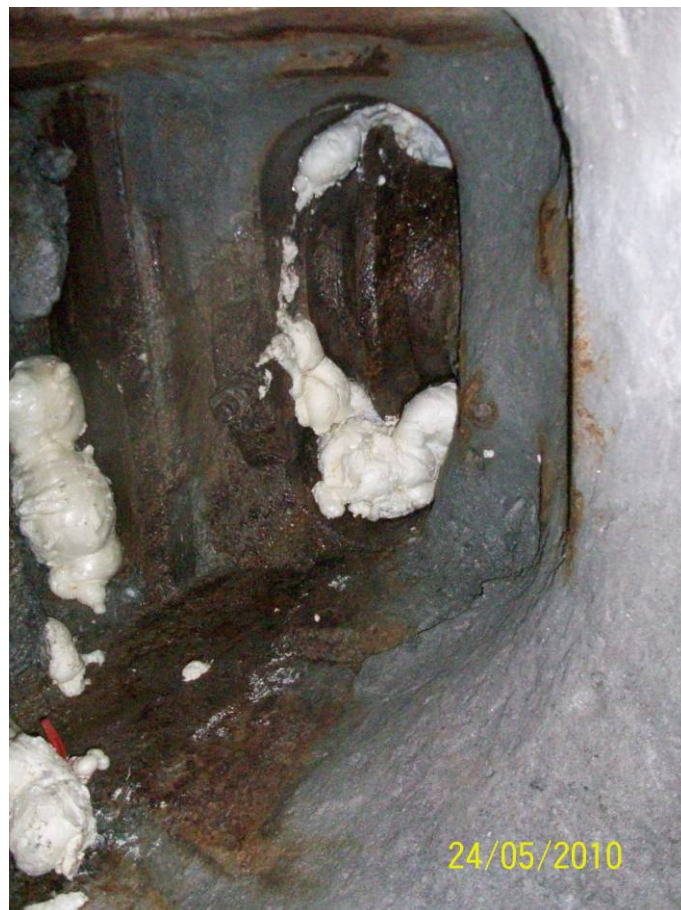
Bild 5: Abgedichtete Meißelkammer im TBM Bohrkopf; TBM West
