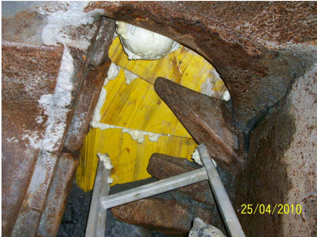
Bild 4: Abgedichtete Öffnung im TBM Bohrkopf; TBM West
