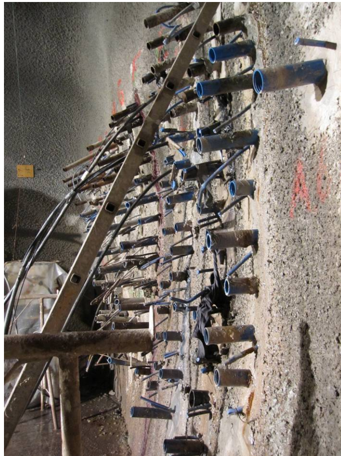
Bild 13: Eingebaute Manschettenrohre; Injektionsnische
