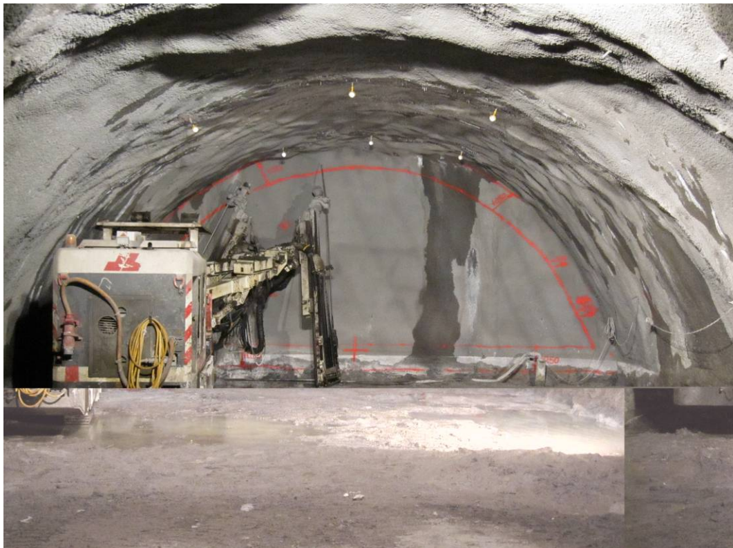
Bild 14: Gegenvortrieb in Richtung TBM West
