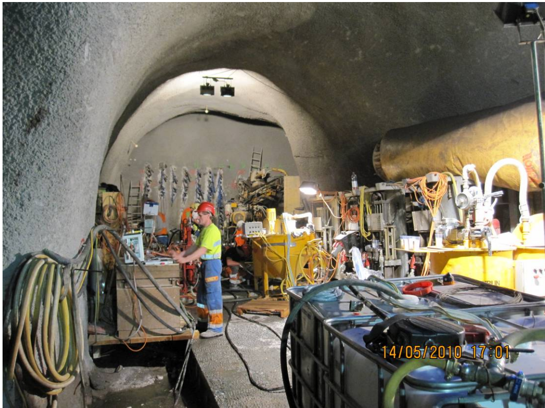
Bild 11: Gelinjektionsarbeiten; Injektionsnische
