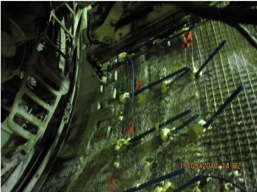
Bild 6: Eingebaute Manschettenrohre, Fächer N,O und P; TBM West
