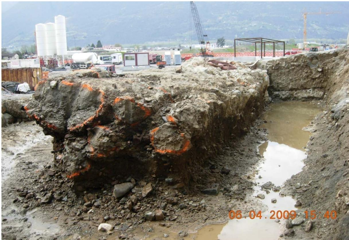
Bild 6: Beispiel freigelegter, horizontaler Probesäulen (Probefeld 1)
