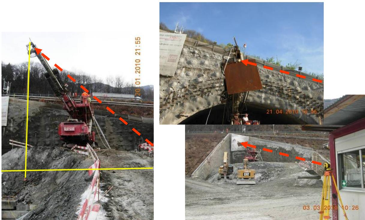
Bild 7: Visualisierung Positionierung Bohrlafette (mit Zielspiegel und Laser)
