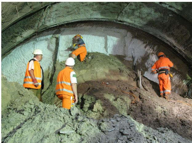
Tal- und Schmelzwassersanden in Kombination mit einem Grundwasserspiegel bis 2m unter GOK erforderten für den ca. 90 m langen bergmännischen Vortrieb als temporäre Sicherungsmaßnahme eine Solevereisung.
