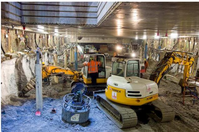
Nach umfangreichen Variantenuntersuchungen für zusätzliche und ergänzende Sicherungsmaßnahmen während des Aushubs wurde entschieden, die kompletten Schlitzwandfugen der Baugruben Vijzelgracht und Rokin mit Frostkörpern auf den Baugruben Innenseite zu sichern.
