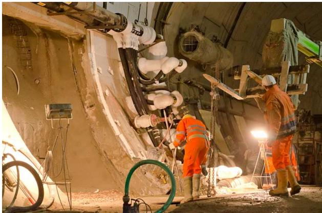
Der 6.970 m lange Tunnel besteht aus zwei, mit Vortriebsmaschinen aufgefahrenen parallelen Einzelröhren. Die Röhren haben einen Innendurchmesser von 9,60 m und sind mit einschaligen Tübbingungen ausgekleidet. Querschläge verbinden die Hauptröhren miteinander. Die jeweils ca. 15 m langen Verbindungsstollen wurden in konventioneller Spritzbetonbauweise hergestellt.
