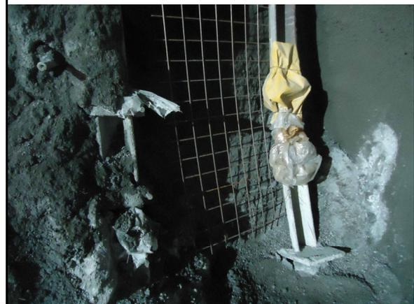
Abbildungen 22: Anpassung und Verstärkung des Bogenfuss in der Linea Val Colla Ausbruchsicherung 10
