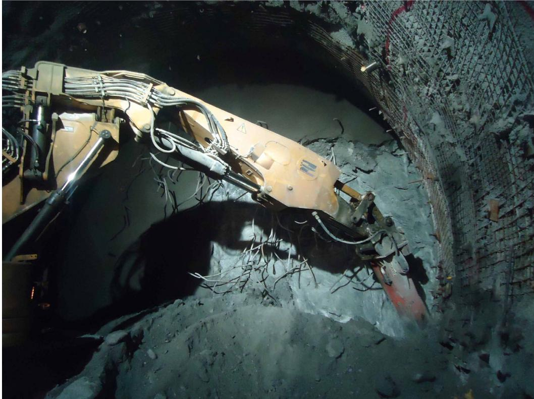
Abbildung 23. Teilausbruch mit Abbauhämmer bei Wiederaufnahme des Vortriebes unmittelbar nach dem Niederbruch
