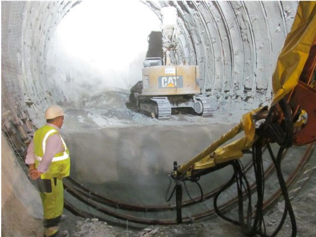
**Abbildung 25.** Ausführen des Sohlenschluss mit entsprechender Brustsicherung
