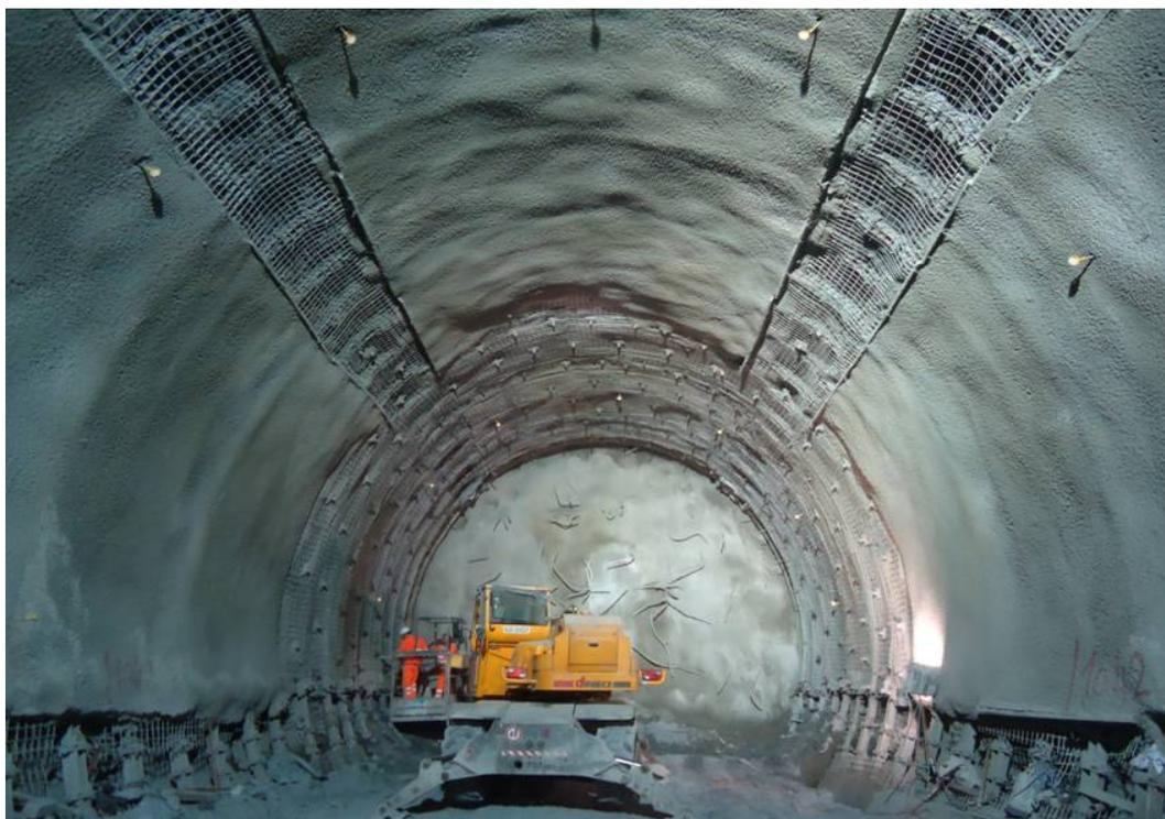
Abbildung 14: Ausführung von Deformationsschlitze (slots) in der Linea Val Colla
