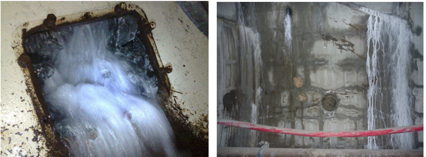
fig. 7a: water ingress / Wasserzutritt; 7b: segment cracks / Rissbilder
