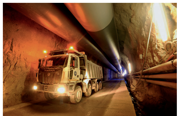
10 Spezielle Lkw zur Stollenschutterung Special trucks for handling muck
