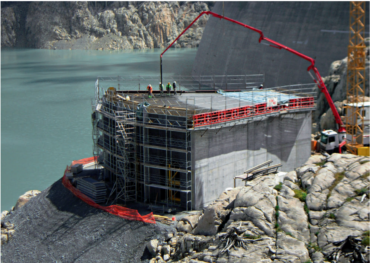
5 Bau des Ein- und Auslaufbauwerks auf Kote 1917 Building the intake and outlet structure at 1917 m
