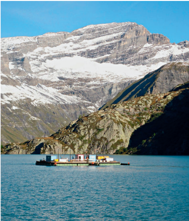
7 Ein- und Auslaufbauwerk wird verschifft (unter der Seeoberfläche, nicht sichtbar) und anschliessend abgesenkt (Intake and outlet structure is moved (under the lake surface, not visible) and subsequently immersed)
