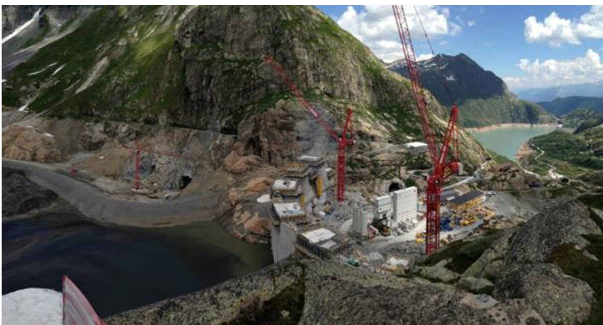
Prises d'eau amont et travaux de surélévation du barrage du Vieux Emosson. Le barrage d'Emosson est visible à gauche
