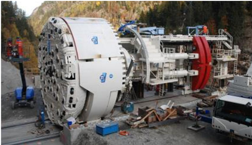
TBM au portail
